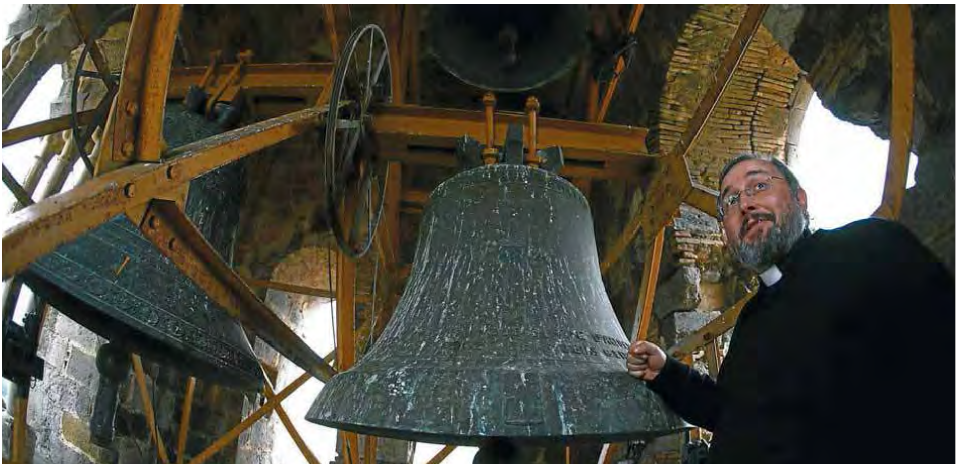
Mossèn Ferran, al campanar de la basílica de Santa Maria de Castelló, el novembre del 2012, quan mostrava els danys de l'edifici gòtic ■ LLUÍS SERRAT
