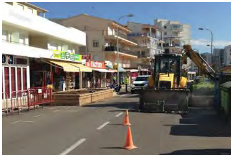
Treballs d'eliminació de les jardineres existents a l'avinguda Gola de l'Estany
