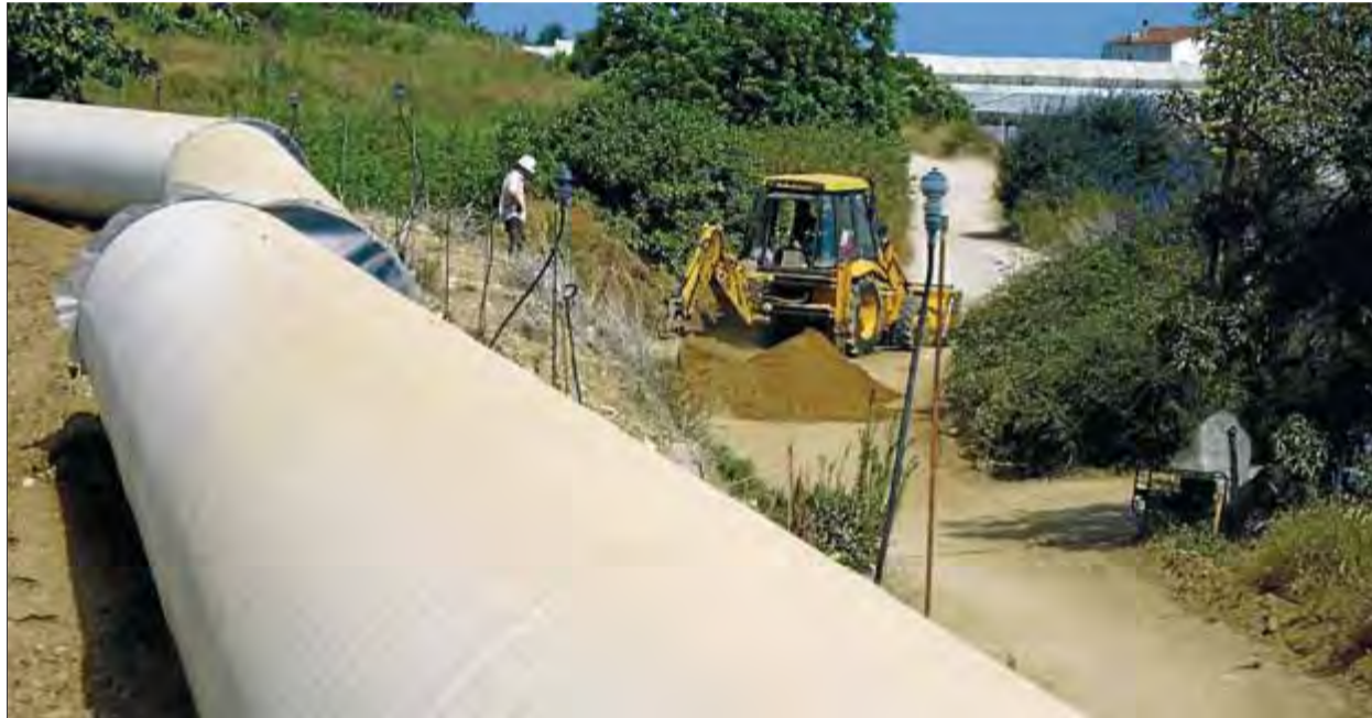
Obres d'una canalització per al proveïment d'aigua al Maresme encarregades a l'ATLL ■ QUIM PUIG
