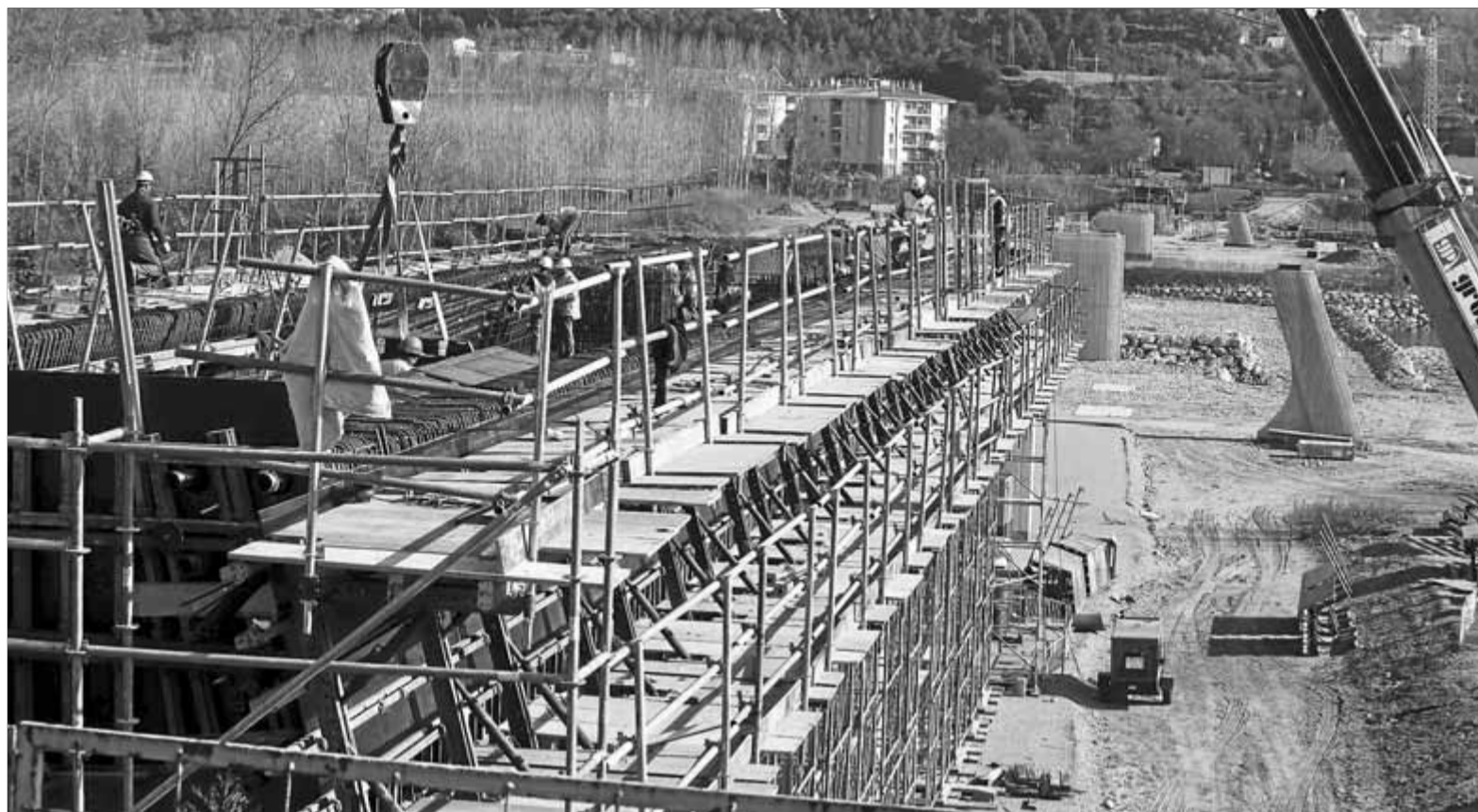
L'estructura del nou pont sobre el Ter a Girona continua avançant dins d'una obra que s'hauria d'acabar el mes d'octubre ■ JOAN SABATER
