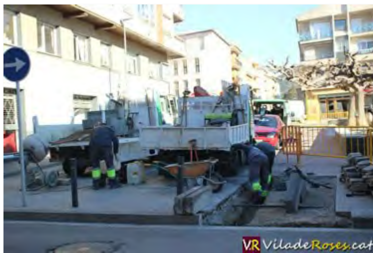
Operaris de ROSERSA treballant en l'obertura del tram del carrer Dr. Fleming
