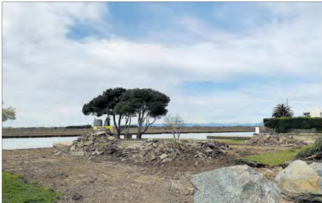
Els treballs que s'estan portant a terme per crear la nova zona verda. AJUNTAMENT DE ROSES
