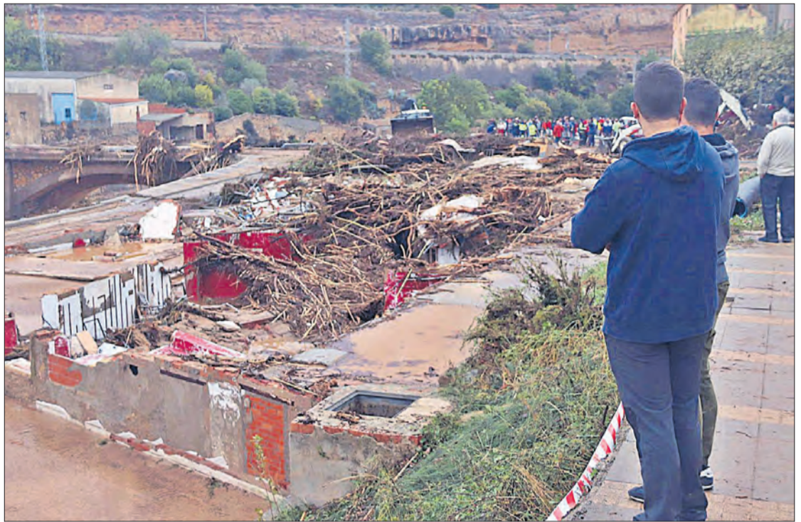
Vista d'un restaurant arrasat pel riu Francolí a l'Espluga de Francolí, a Tarragona. ACN
