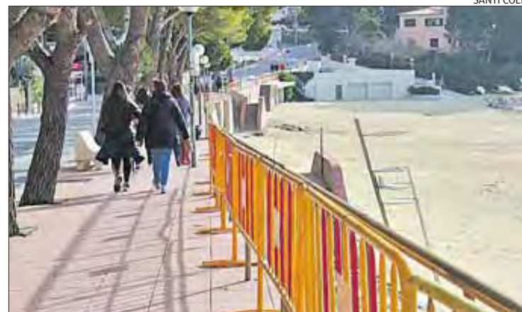
Les tanques d'obra protegeixen la barana en reparació.
