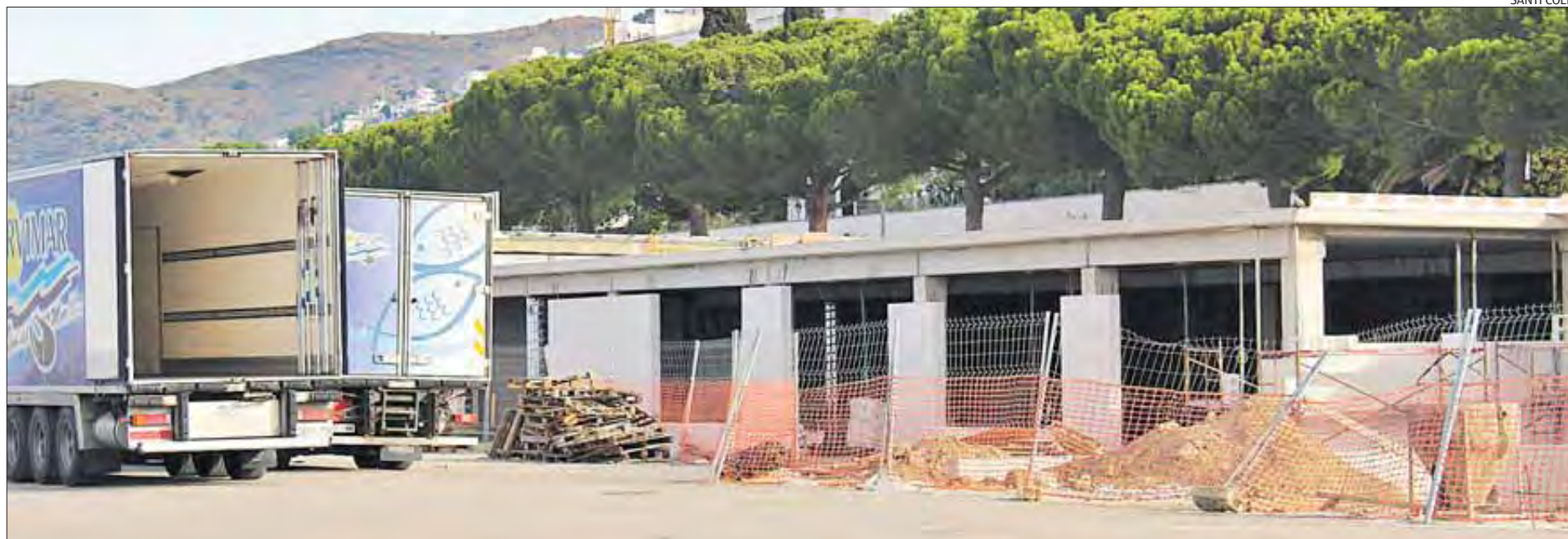
El nou equipament industrial dona continuïtat a les edificacions existents en paral·lel al port pesquer i la carretera del Far.
