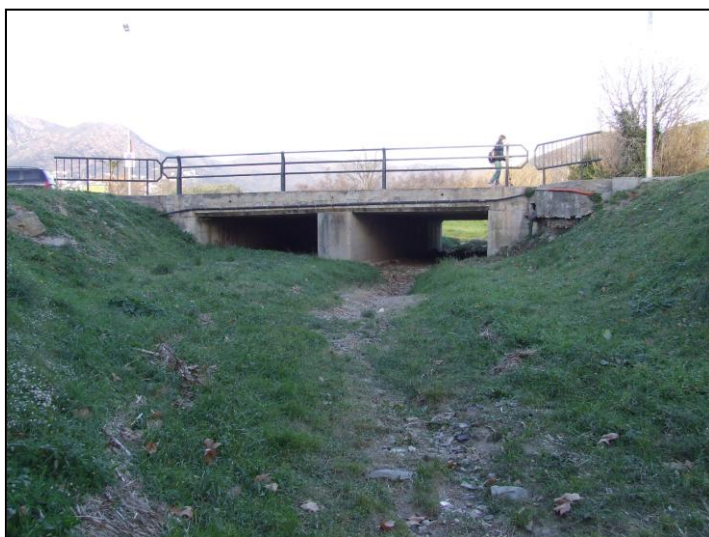
Foto 11. Pont de la ronda de circumval·lació consistent en dos calaixos de 4mx2m..
