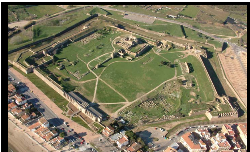
Vista general recinte Ciutadella
