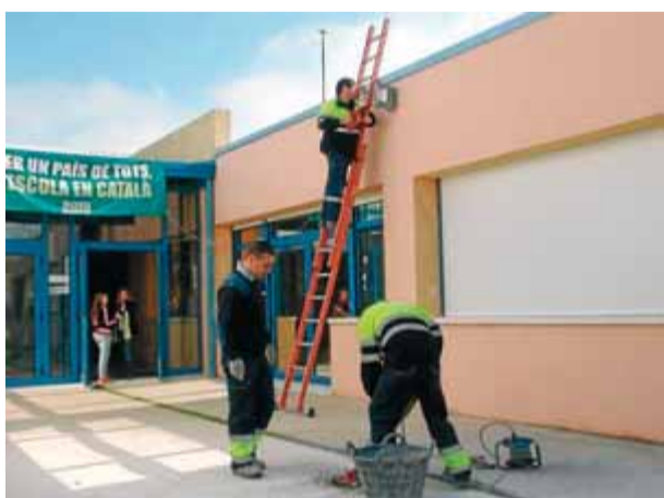
Operaris traient els fanals i instal·lant les noves a l'escola Forn d'Anells de Fornells de la Selva ■ EL PUNT AVUI
