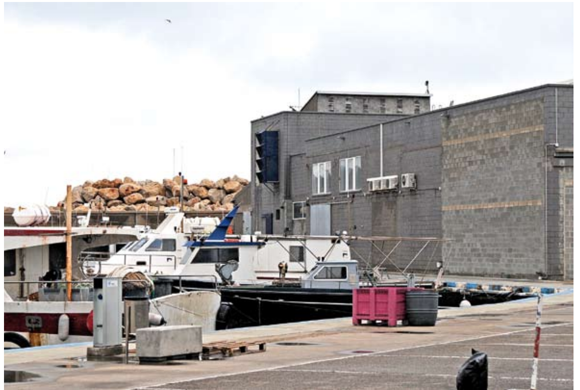
CANVI D'IMATGE. Aquest estiu els visitants ja no veuran l'edifici mig derruït, cosa que millorarà la imatge del port
