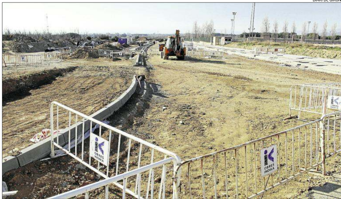
Les obres del vial Nord de Roses, el que serà l'accés al CEIP Montserrat Vayreda.
