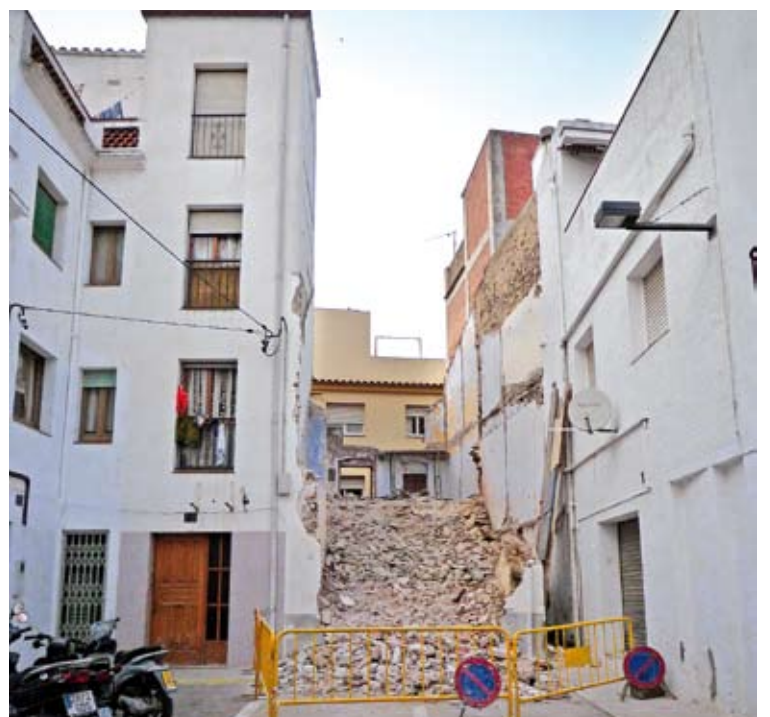
CARRER PALMEROLA. D'aquí a unes setmanes aquesta via quedarà oberta
