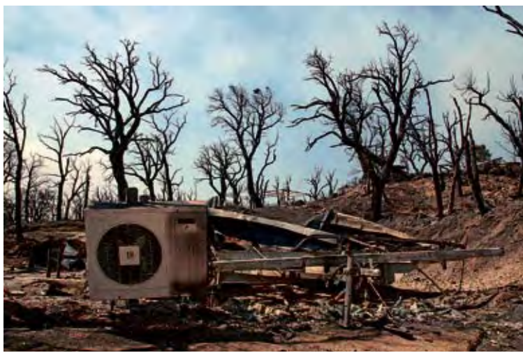
LES PEDRES. Estat en el que van quedar les instal·lacions del càmping
