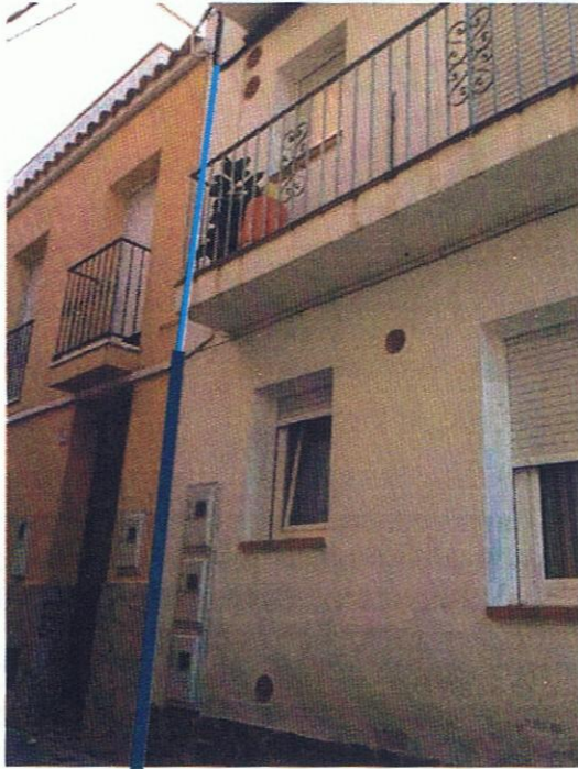
Foto 1: Detall conversió B.T. aèria-soterrada
