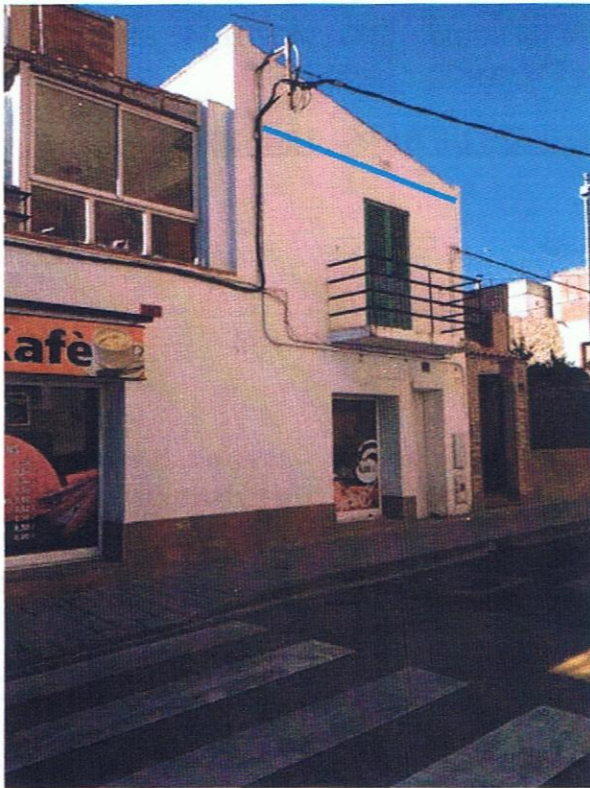
Foto 1: Detall traçat línia B.T. trenada per façana.
