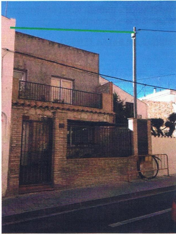
Foto 1: Detall traçat línia B.T. aèria .
