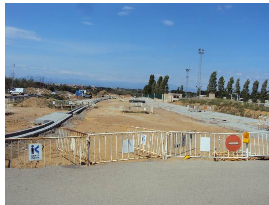
Foto núm. 4 Estat general de les obres des de la rotonda
