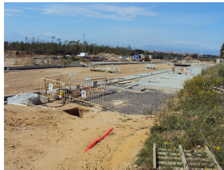
Foto núm. 8 Vorera nord
