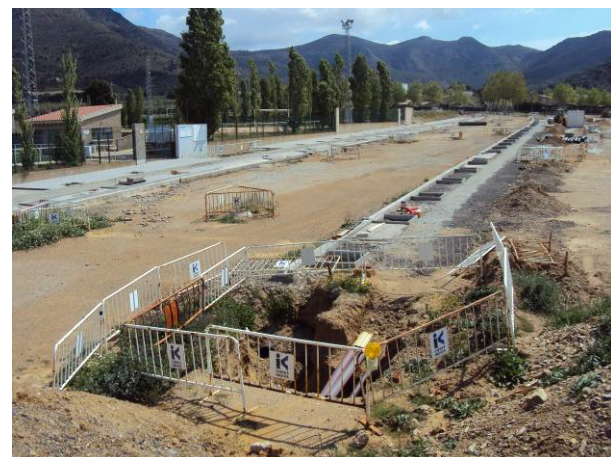
Estat general de les obres del final del vial (excavació del pou de bombament)
