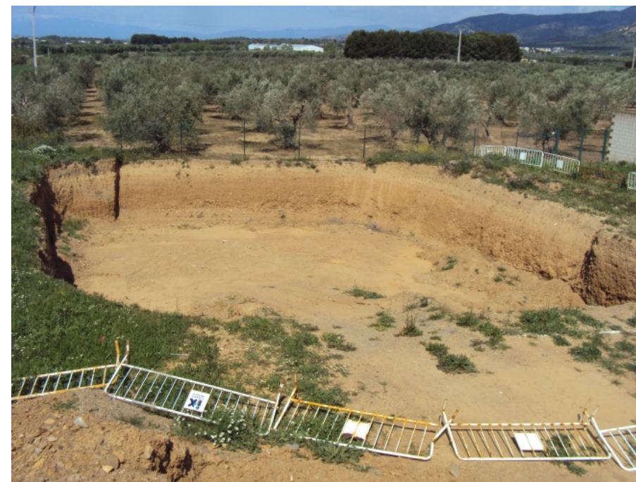
Foto núm. 18 Excavació bassa de laminació
