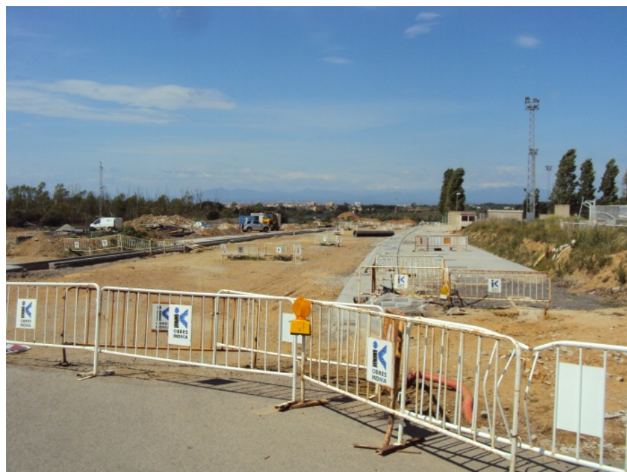
Foto núm. 7 Vorera nord
