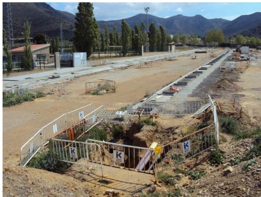
Foto núm. 5 Estat general de les obres del final del vial (excavació del pou de bombament)
