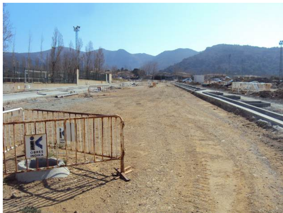
Foto núm. 1 Vista general del vial
