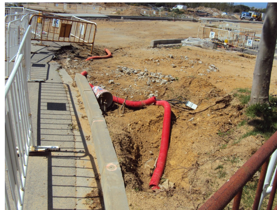
Foto núm. 26 Detall entroncament rotonda
