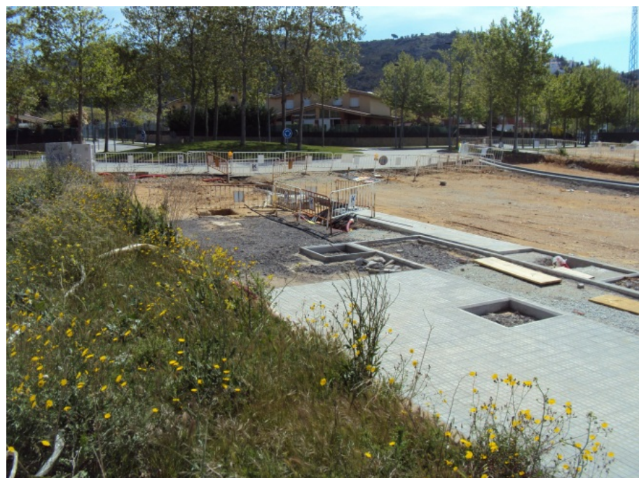
Foto núm. 11 Vista inici obra (rotonda)
