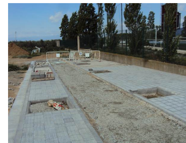
Estat actual de la vorera nord
