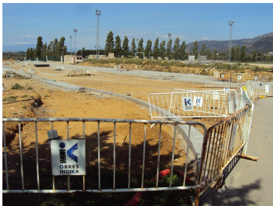
Foto núm. 27 Detall entroncament sud rotonda
