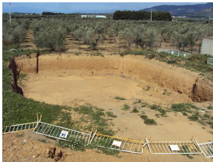
Excavació executada de la bassa de laminació d'aigües pluvials.
