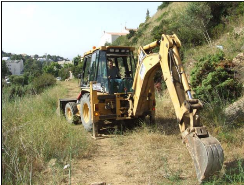
Foto 8. Execució cala nº 6.
