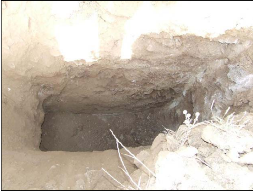
Foto 7. Interior cala nº 5
