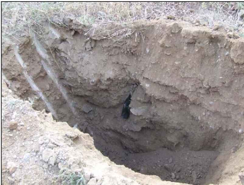
Foto 2. Cala mecànica nº 2, amb rebliment fins a 1,5m. Es veuen les crostes paral·leles que corresponen a cada tongada de compactació
