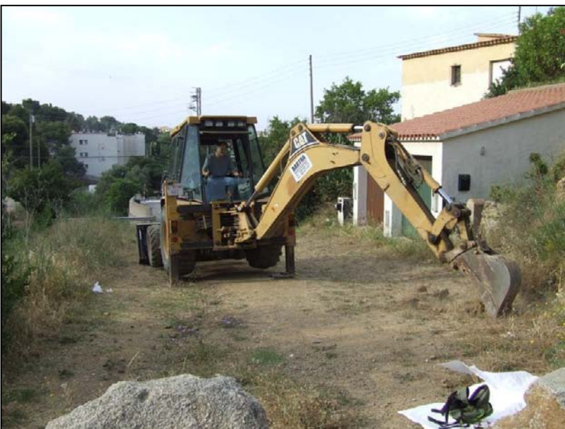
Foto 3. Execució cala nº 3.
