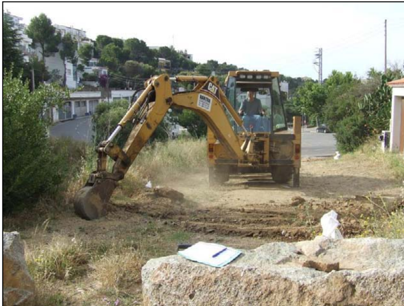
Foto 5. Execució de cala n° 4.
