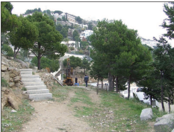
Foto 5. Sondeig S1 des del final del futur aparcament.
