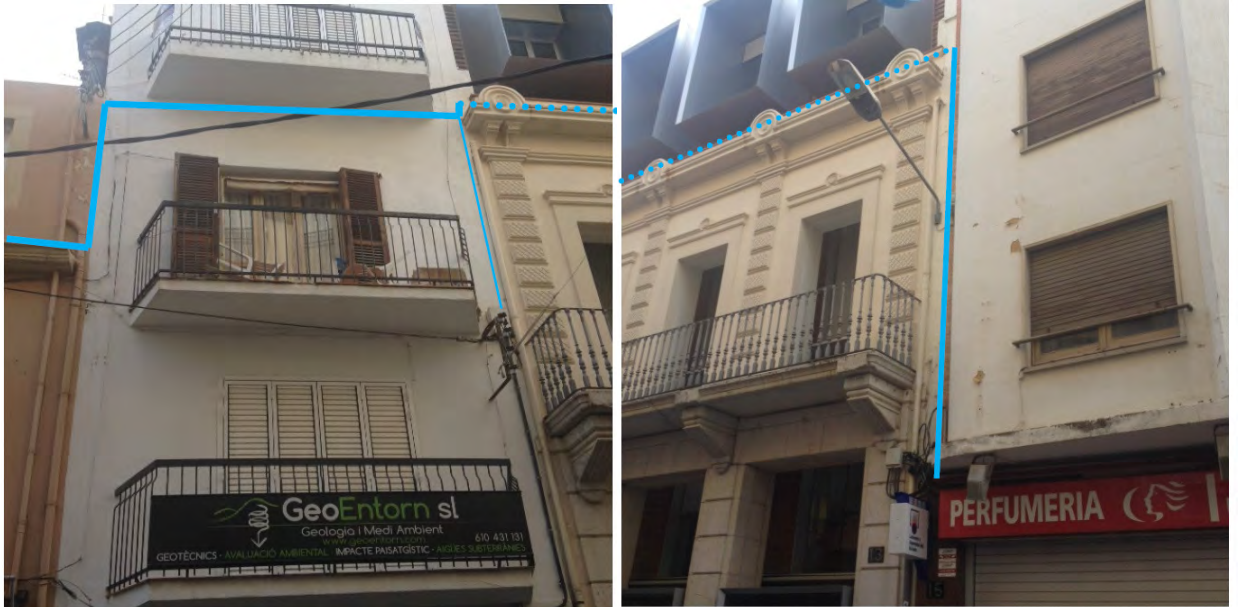
Foto - Detall traçat xarxa B.T. en façana.
