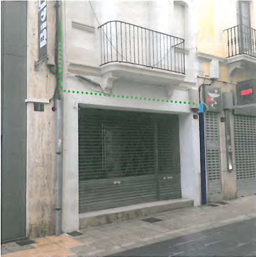
Foto - Detall substitució derivació xarxa B.T. existent .
