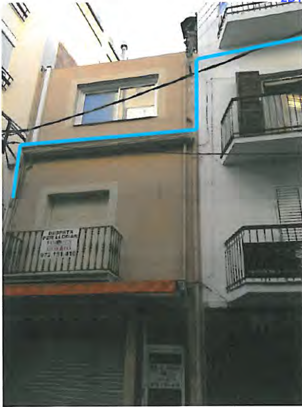
Foto - Detall traçat xarxa B.T. en façana.
