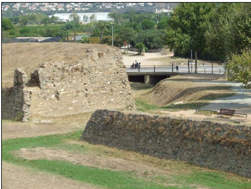
Foto 1. Tram del rec Fondo sobre el que s'actuarà entre el pont de la ronda de circumval·lació i l'entrada al fossar.
