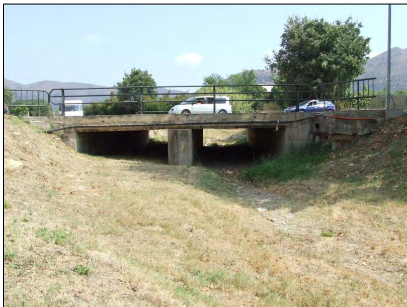
Foto 3. Obra de fàbrica del pont sobre la ronda de circumval·lació, aigües avall; ja dins de l'àmbit d'actuació.
