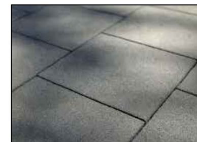
PAVIMENT PECES FORMIGÓ
