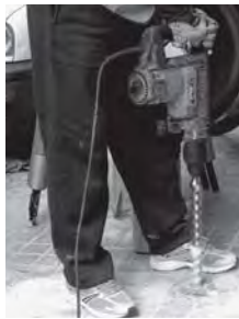
2 Perforación orificios
