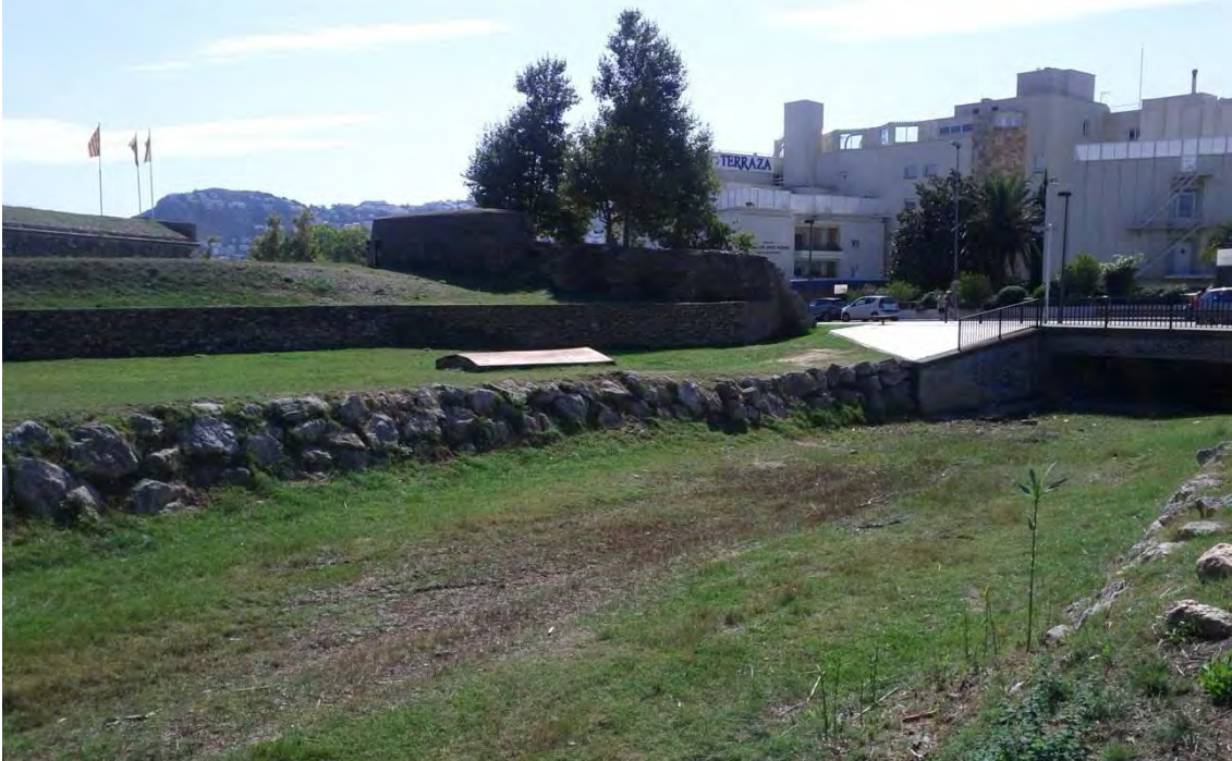
Foto 5: Vista del tram final de l'actuació des del marge dret de la riera Trencada. Al fons hi ha el pont de l'Avinguda de Rohde amb l'aleta de formigó que continua amb la protecció d'escullera. També es pot veure la coberta de la caseta de la Font de la Vituà, en la part central de la imatge.
