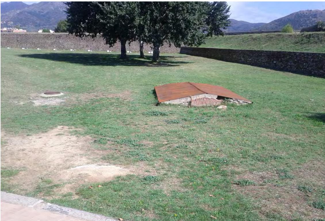
Foto 6: Vista de la coberta de la caseta de la Font de la Vituà i de la tapa de la cambra de línies de telecomunicacions.
