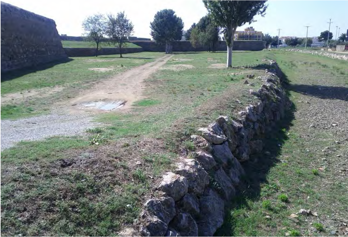
Foto 3: Vista de la protecció amb escullera del marge esquerre de la riera Trencada, en el primer tram de l'actuació, després del pont de la Ronda de Circumval·lació. També es pot veure el tram sense protecció d'escullera fins la punta de la muralla.
