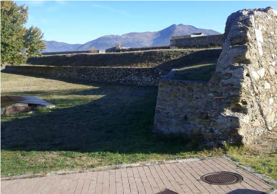
Foto 7: Vista de la muralla de la Ciutadella i de la coberta de la Font de la Vituà des de la vorera de l'Avinguda de Rhode.
