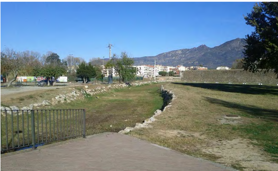
Foto 8: Vista de la riera Trencada en el tram final de l'actuació, des de la vorera de l'Avinguda de Rhode, just al costat del pont. En aquest tram els dos marges estan protegits amb escullera. També es pot veure la barana metàl·lica que hi ha sobre l'aleta del pont, i la tapa de la cambra de les línies de telecomunicacions.
