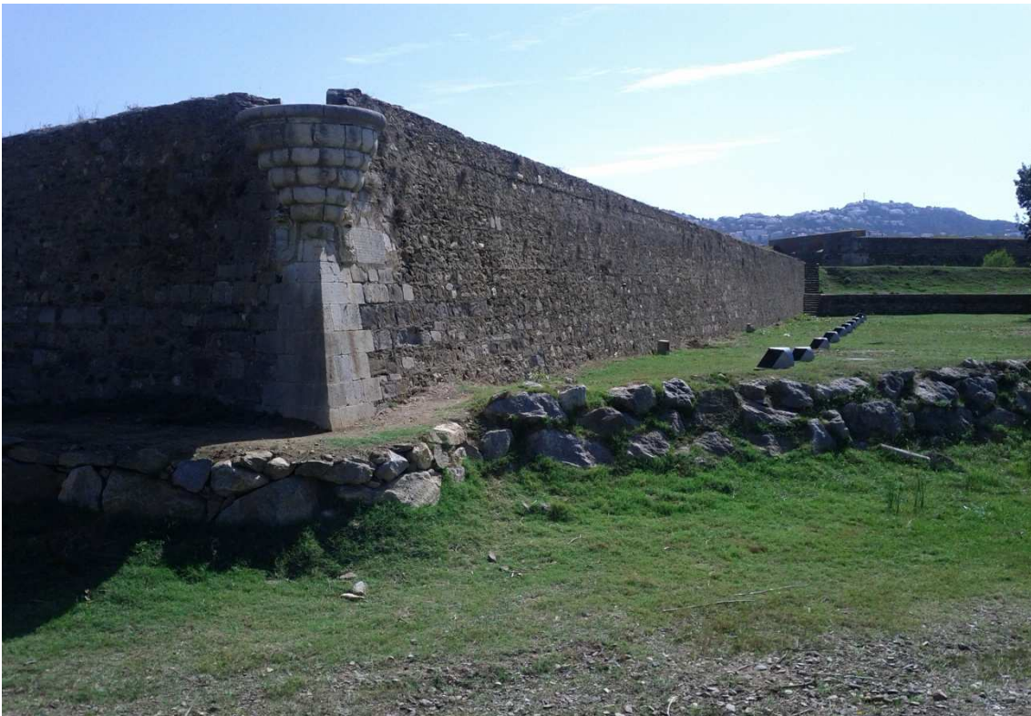
Foto 4: Vista de la punta de la muralla amb la protecció d'escullera en la base. A la dreta es poden veure els punts d'enllumenat existents que es preveu substituir.
