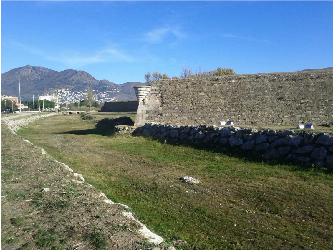
Foto 9: Vista de la punta de la muralla de la Ciutadella, que queda al mig de l'actuació. És el punt on la muralla s'acosta més a la llera de la Riera Trencada. La protecció d'escullera existent només es troba en la pròpia punta i cap a aigües avall; cap a aigües amunt ja no n'hi ha fins a l'alçada del pont de la Ronda de Circumval·lació.
