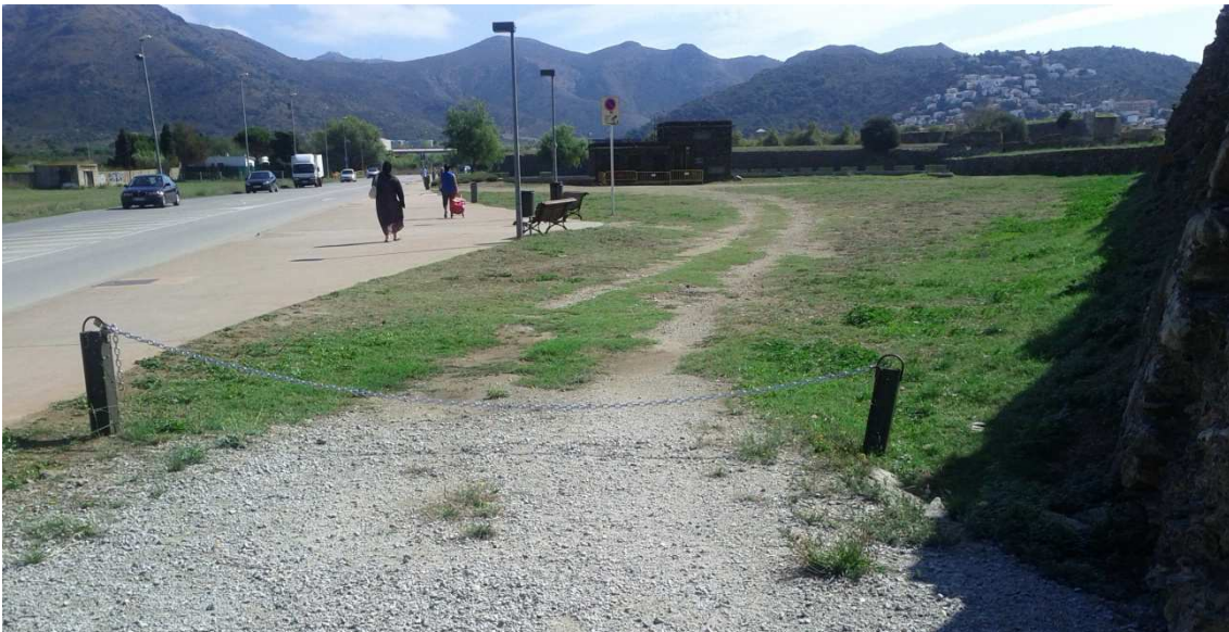
Foto 2: Vista des del marge del pont de la Ronda de Circumval·lació. Al fons es veu el dipòsit d'emmagatzematge d'aigua potable. També es pot veure l'enllumenat i el mobiliari.
