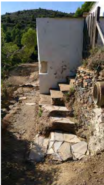
Final tram. PK 4+950
