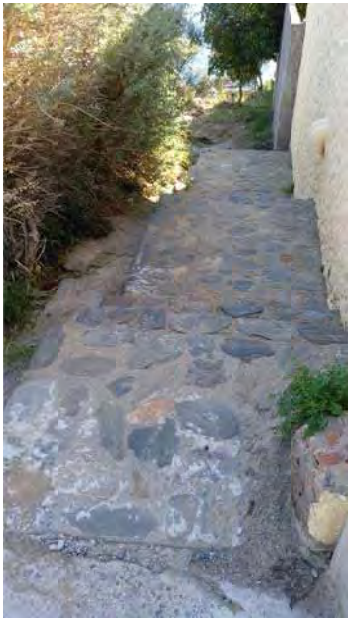
Inici tram-baixada existent
