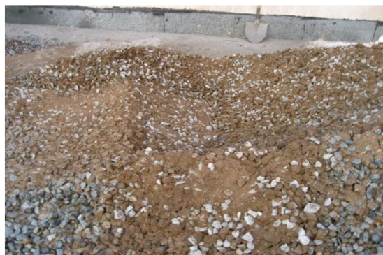
S'aprecia la homogeneïtat de la barreja
