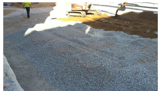
Esquerra material ja barrejat i a la dreta la aportació de la resta de terra vegetal.
