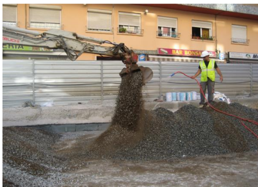
Procés paral·lel de barreja i humectació
