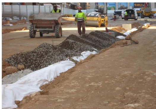
Distribució i reblert sòl estructural
