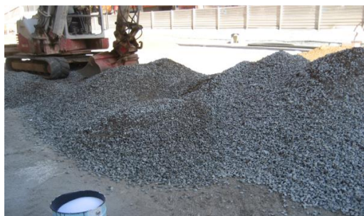
Estesa material barrejat per la incorporació de l'hidrogel i l'aigua
