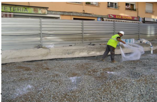
Moment del inici de l'aplicació de l'hidrogel
