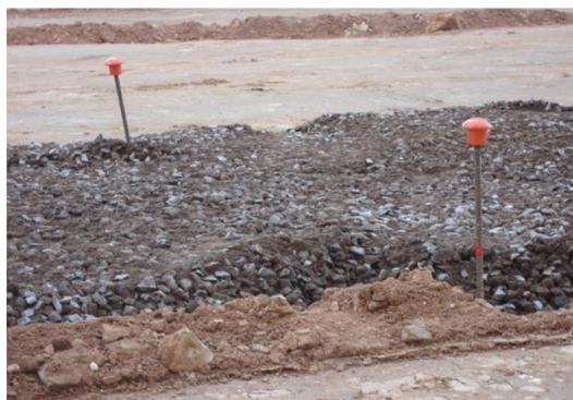
Nivell de reblert i estesa
