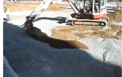
Incorporació de terra vegetal
