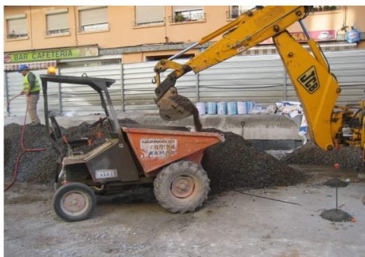
Carrega de sòl estructural en bolquet
