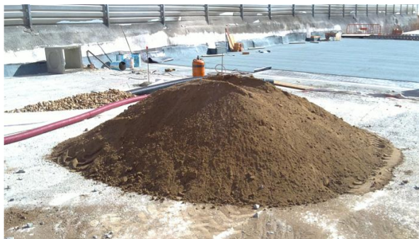
Acopi de terra vegetal en l'obra
