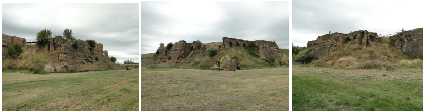
Vistes de les quatre cares del baluard des del nivell baix del fossat
