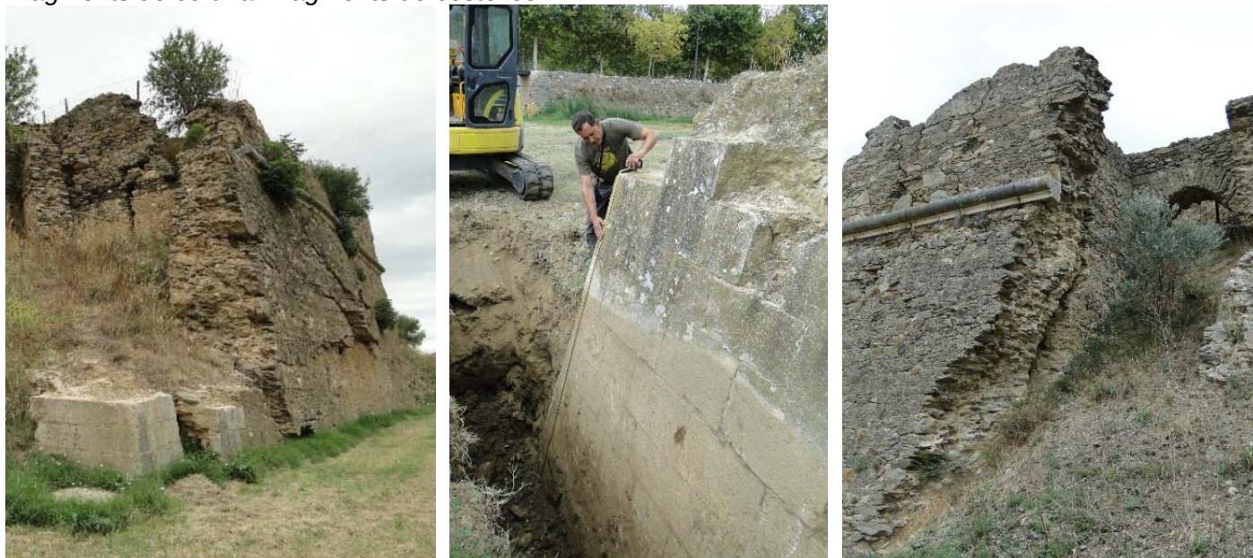
Massa i detall. Cates per comprobar la fondària de llenç enterrada (2m) pels sedimentS del fossat.
