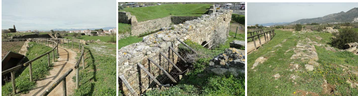
Vistes del recorregut actual pel nivell alt del camí de ronda
