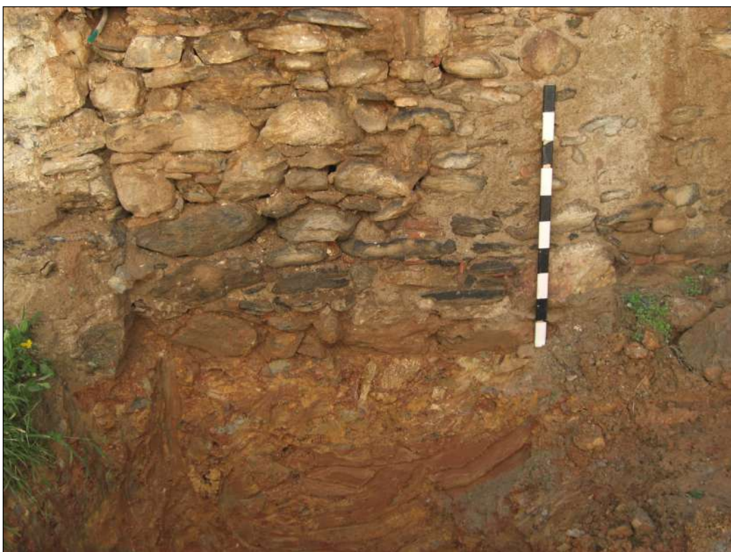
Fig. 8 Detall dels nivells de fonamentació del mur est, i el parament més antic.
