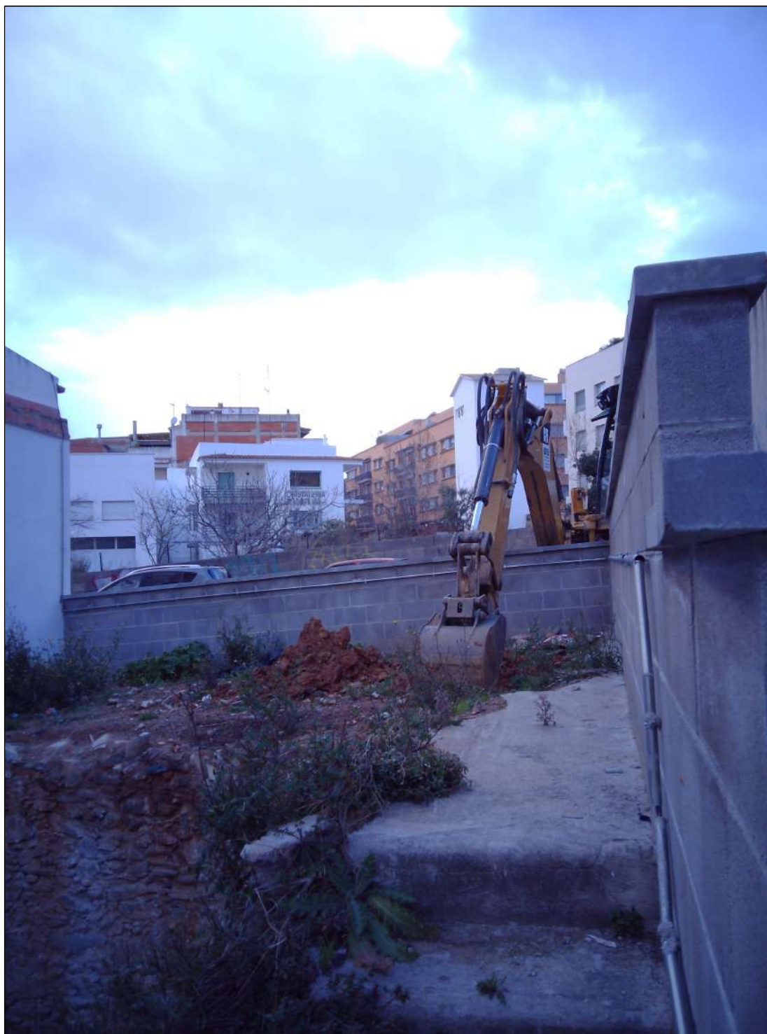
Fig. 3 l'extracció de terres del sondeig 1 amb la màquina retroexcavadora.
