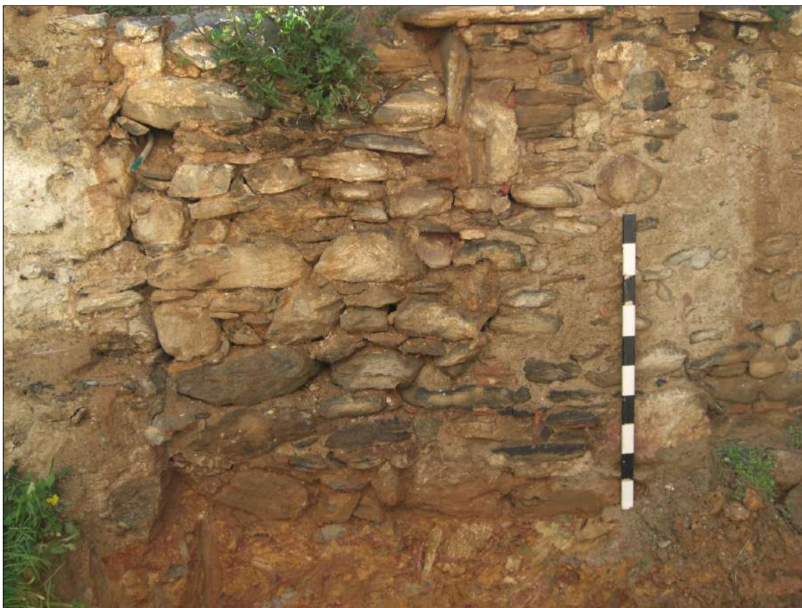
Fig. 9 Detall del mur est amb la finestra tapiada, i com s'assenta sobre el subsòl natural.
