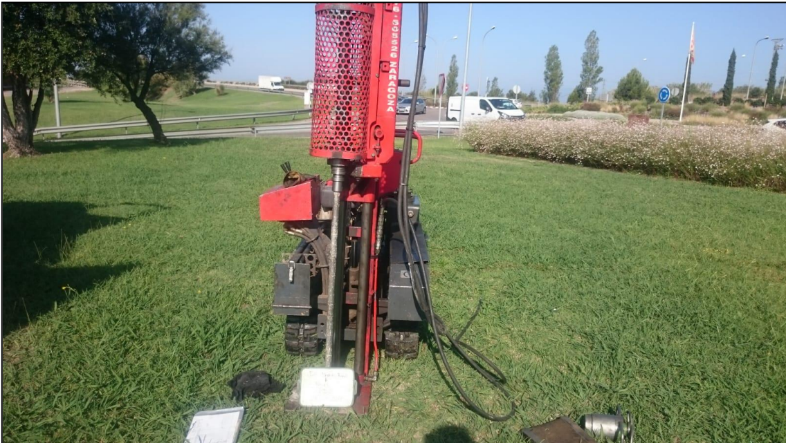
Foto 2. Execució del PD-2.
