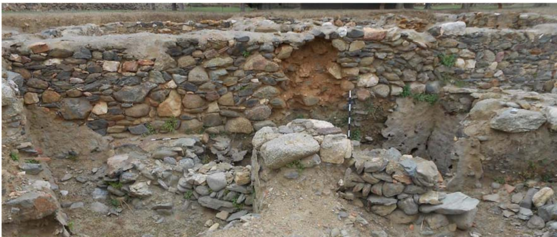
Detall del mur nord amb mostra d'un esfondrament parcial.
