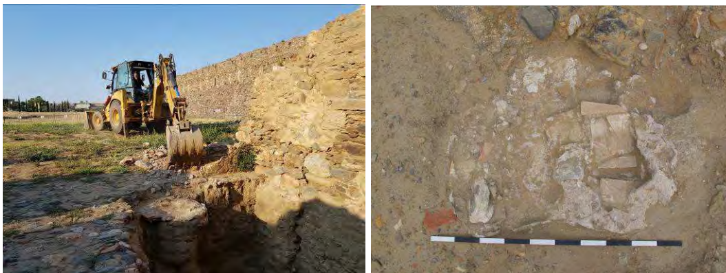
Imatge del pilar esquerra de la peça de morter que va caure durant la intervenció on es col·locaria la porta, i del fragment del pilar de la dreta encara in situ.
