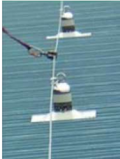
Linia de vida provsional per a obra i posterior linia de vida definitiva per a manteniment
