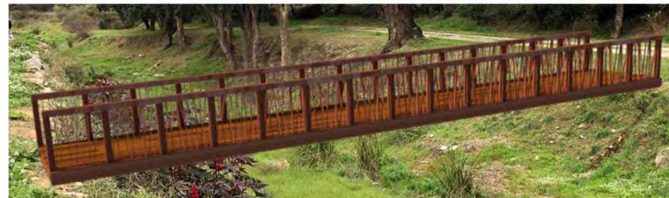
Figura 4. Sobreposició passarel·la tipus barana estructural
