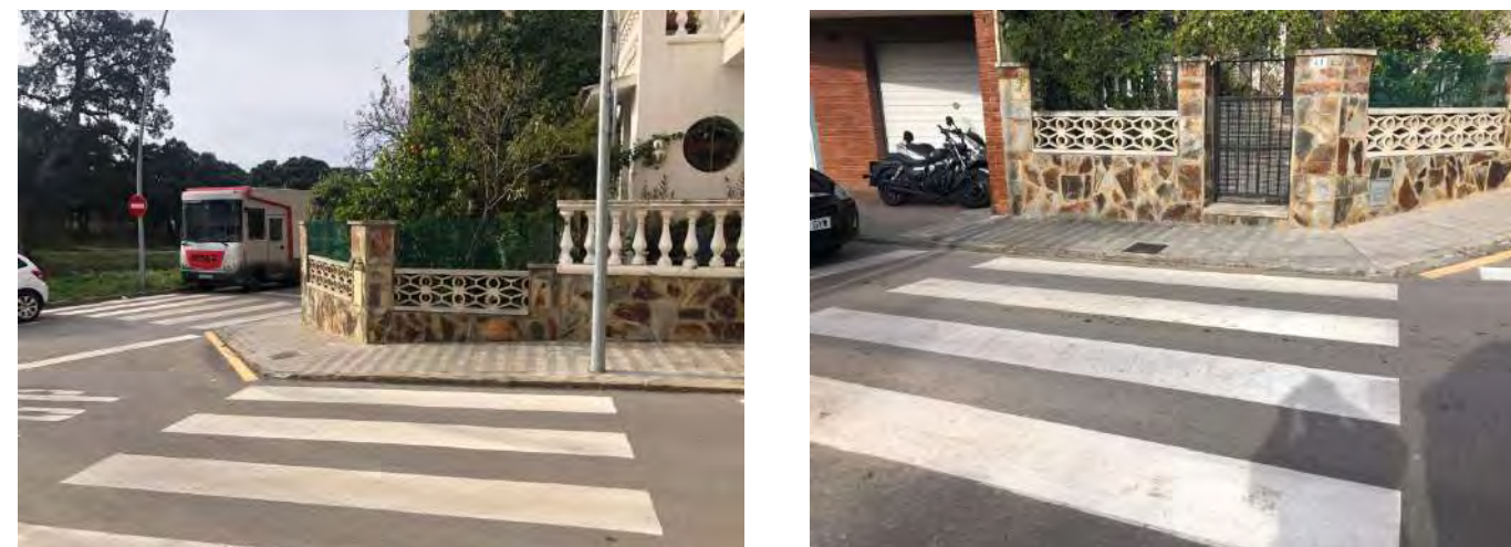
Figura 7. Vistes de la vorera del carrer Oslo
