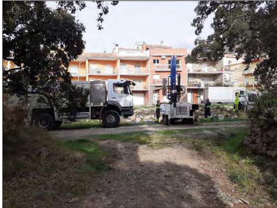
Foto 5. Ubicació del sondeig S-2, des de l'embocament del camí dels Grecs.
