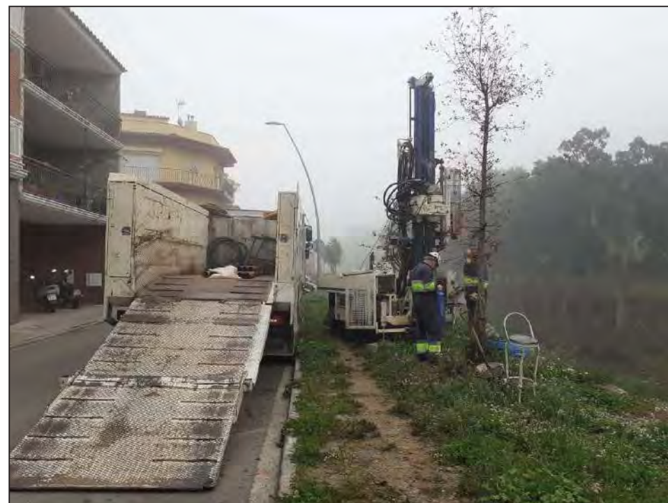
Foto 2. Ubicació del sondeig S-1 al carrer Oslo, 37
