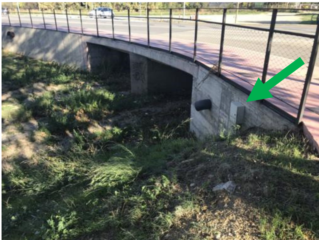
Punt de connexió actual de les lluminàries a l'enllumenat vial
