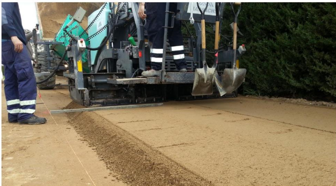
Imatge del control de gruix en el moment de l'estesa
