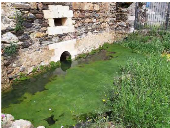
Figura 6: Porta d'accés al cos de guàrdia original, aquest element mai g estigué en funcionament i fou ràpidament amortitzat. No obstant això, ens permet observar com el nivell d'accés des del fossat al pati d'armes era més de dos metres inferior a l'actual.
