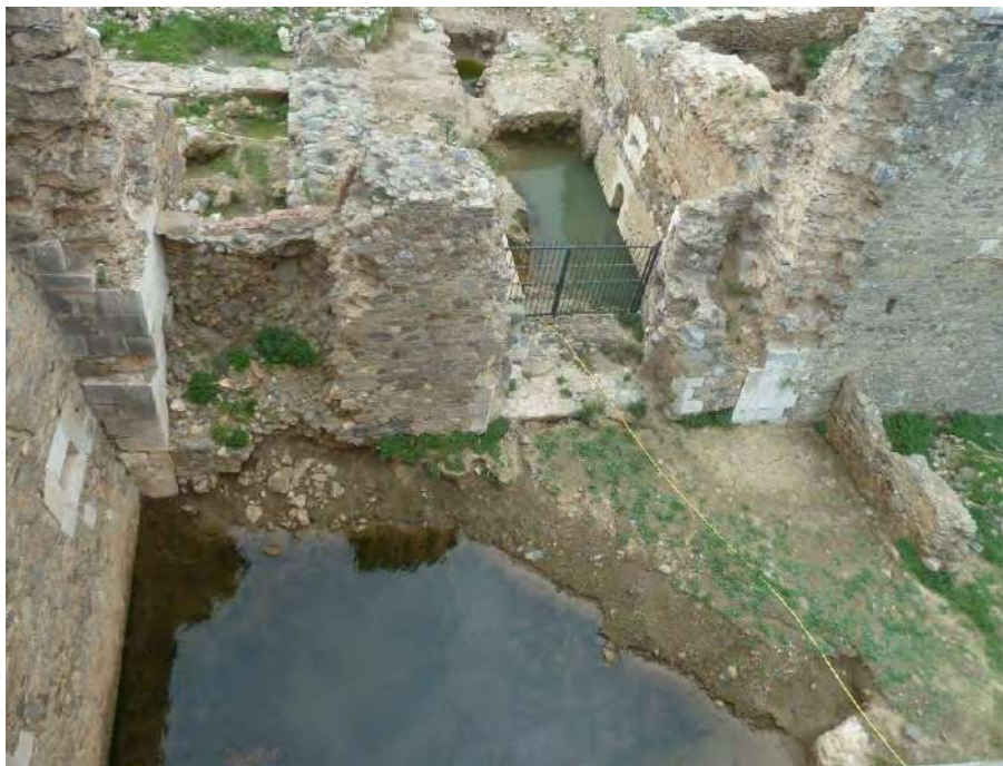
Figura 5: Porta de Terra en procés d'excavació. Hi podem observar com del portal original només es féu l'encastament en pedra calcària dels laterals, mentre la resta de l'obra mai fou bastida, la qual cosa obligà a fer un seguit de pedaços que permetessin posar-la en condicions de defensa.
