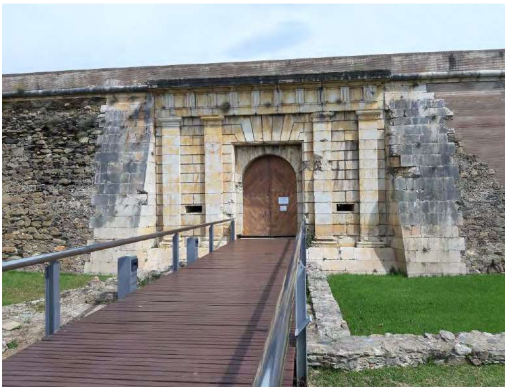
Figura 4: Porta de Mar de la Plaça Forta de Roses. És tracta d'un portal de carreus bastit a imitació de l'arquitectura clàssica, en estil dòric. La necessitat d'encabir-hi dues troneres laterals per afalconet –petits canons de retrocàrrega– impedié fer-hi un triple portal.
