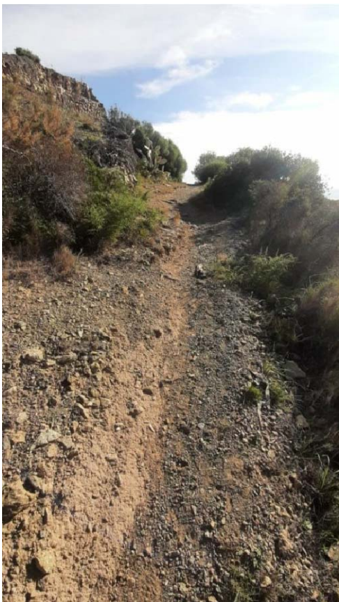
12. PERFILAT DEL CAMI EXISTENT, 1.5m D'AMPLADA MÍNIM NETEJA DE PEDRA SOLTA I REOMPLERT AMB SAULÓ REPOSICIÓ DE VEGETACIÓ AUTÓCTONA EN ELS LÍMITS MOFIFICACIÓ PENDENT LATERAL I ESGRAONAT
