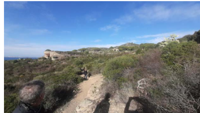
13 . PANORÀMICA AMB EL BUNKER DE FONTS CAMI DE TERRA COMPACTADA AMB FORTA PENDENT LATERAL
