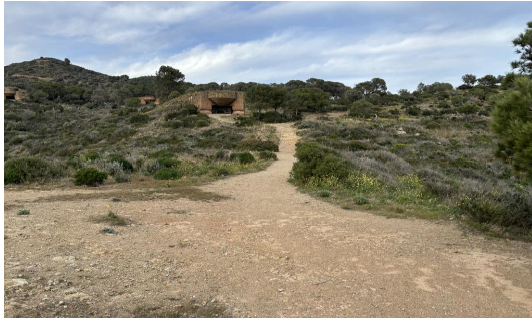
Fotografia 1. Estat actual de l'itinerari i el búnquer.
