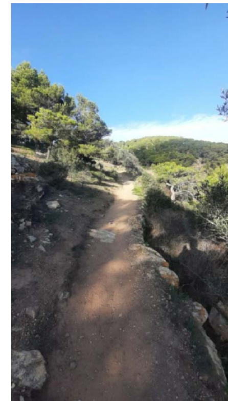
27. ITINERARI ENMARCAT SOBRE MUR
