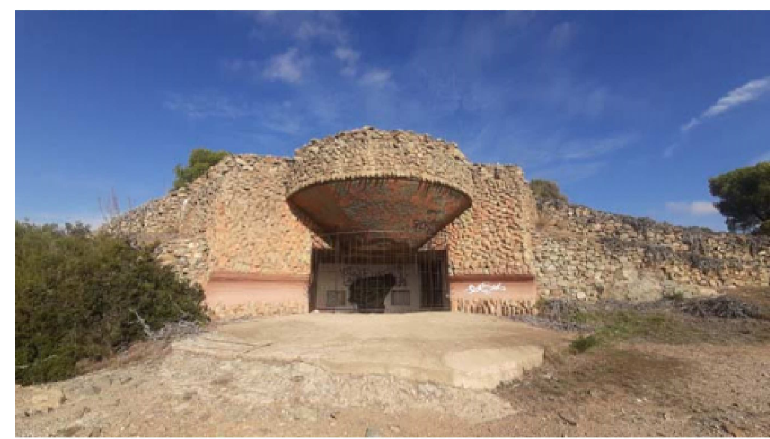
30 INTERSECCIÓ DE CAMINS AL BUNKER CAMI DE TERRA COMPACTADA AMB GRAVA SOLTA
