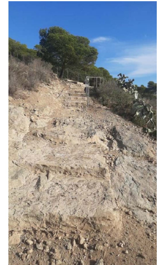
21. RAMPA ESCALA EXISTENT ■ NETEJA DE LA PEDRA SOLTA
