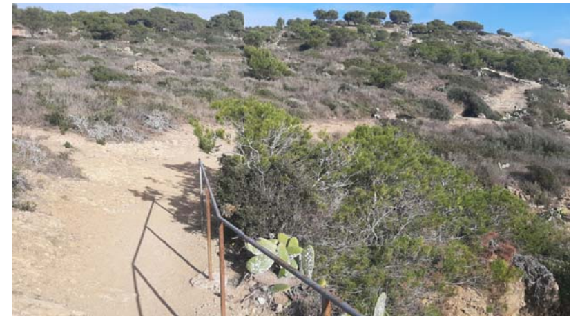
20. ITINERARI COMPARTIT AMB CAMÍ DE RONDA TRAM TERRA COMPACTADA AMB PENDENTS SUAUS
