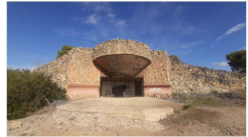
30. INTERSECCIÓ DE CAMINS AL BUNKER CAMI DE TERRA COMPACTADA AMB GRAVA SOLTA
