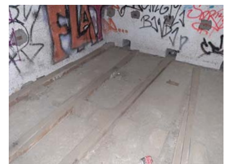
05_ESPAIS LATERALS. PAVIMENT I TAULONS FUSTA
