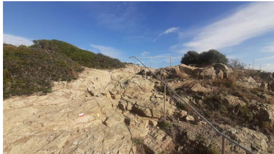
19. SUBSTITUCIÓ BARANA D'ACORD AMB PLÀNOL DE DETALL ■ NETEJA DE LA PEDRA SOLTA
