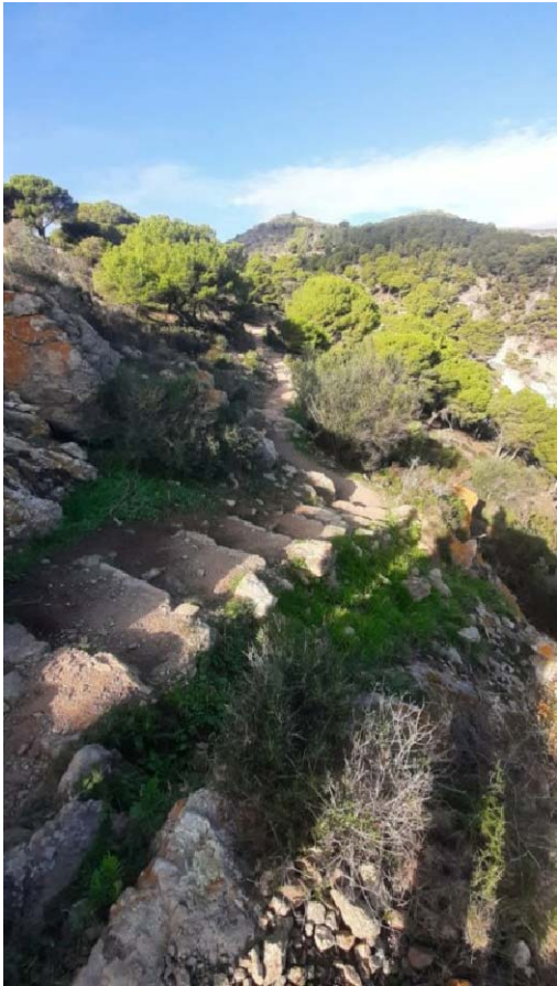
25 CAMÍ DE RONDA. TRAM ESGRAONAT AMB FORTA PENDENT COL·LOCACIÓ DE BARANA DE SEGURETAT
