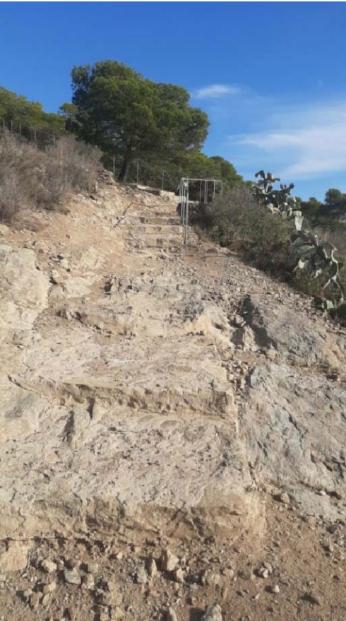
21. RAMPA ESCALA EXISTENT ▀ NETEJA DE LA PEDRA SOLTA
