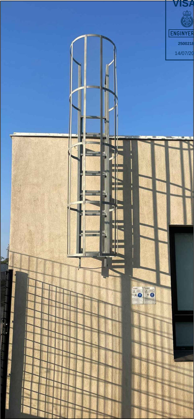
Escala de gat existent en façana
