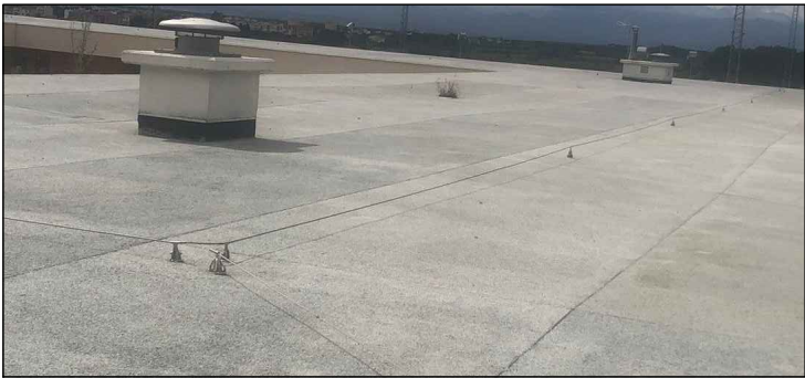
Línia de vida existent en coberta
