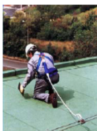
Sistema de pas del mosquetó per anclatge intermitent
