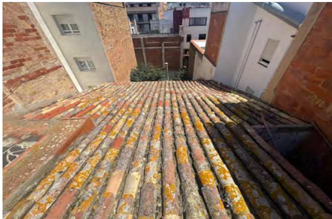
VISTA GENERAL COBERTA INCLINADA
