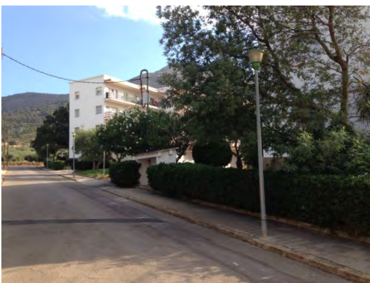
Lluminària: Urbanització en columna Alçada làmpada: 4 m Làmpada: Vm 125 W
