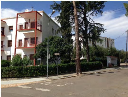
Lluminària: Urbanització en bàcul Alçada làmpada: 8 m Làmpada: Vm 125 W
