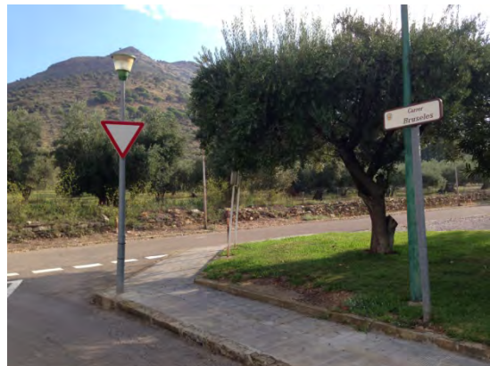
Lluminària: Urbanització en columna Alçada làmpada: 4 m Làmpada: Vm 125 W
