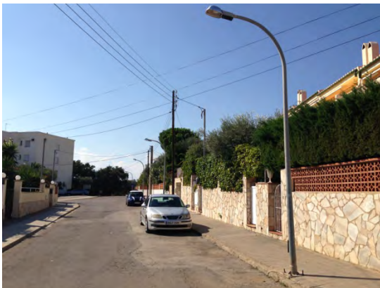
Lluminària: Urbanització en bàcul Alçada làmpada: 6 m Làmpada: Vm 125 W
