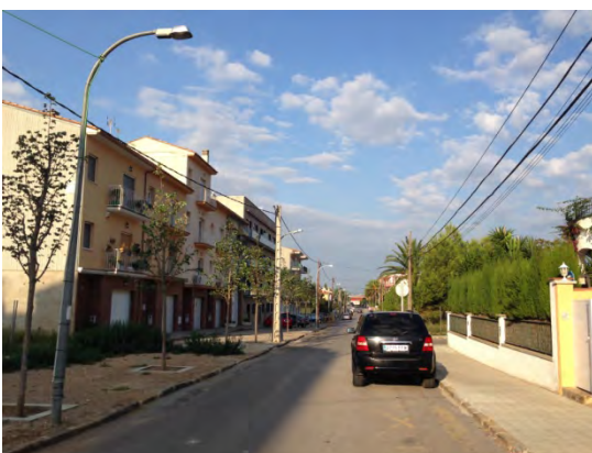
Lluminària: Urbanització en bàcul Alçada làmpada: 6 m Làmpada: Vm 125 W
