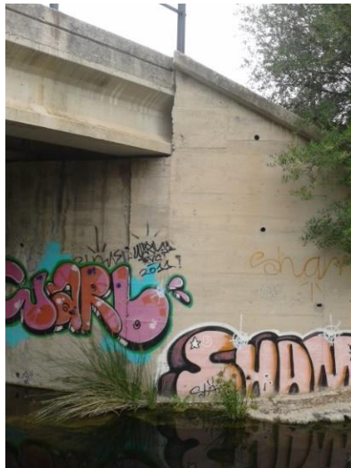
L'estrep del marge dret i l'aleta d'entrada es troben completament descalçats
