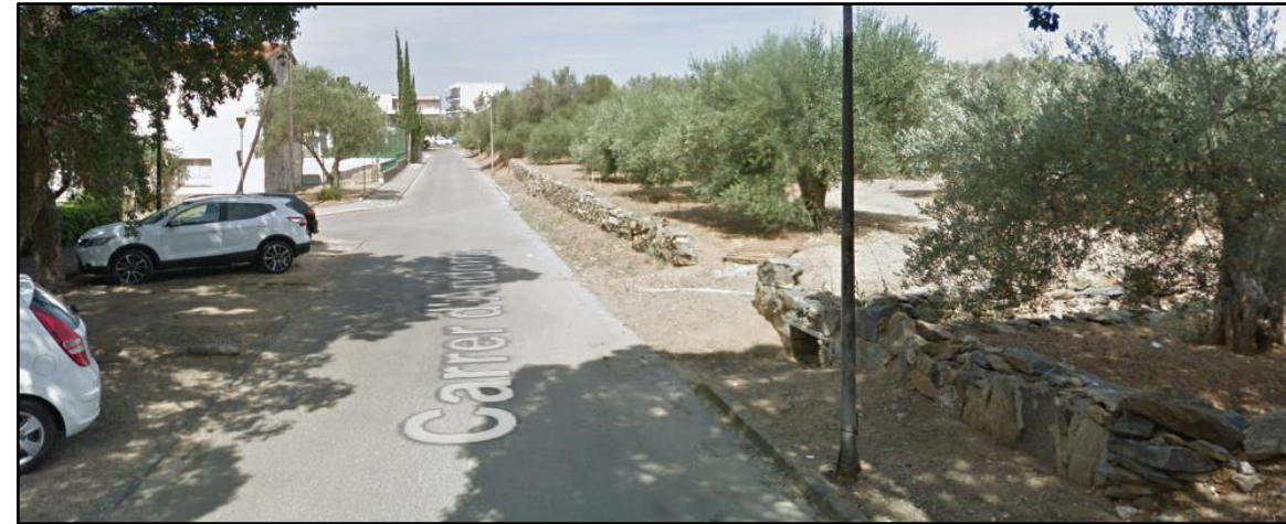
Vista de la llera de l'altre rec en la intersecció amb el carrer d'Andorra, a l'alçada del carrer Mònaco
