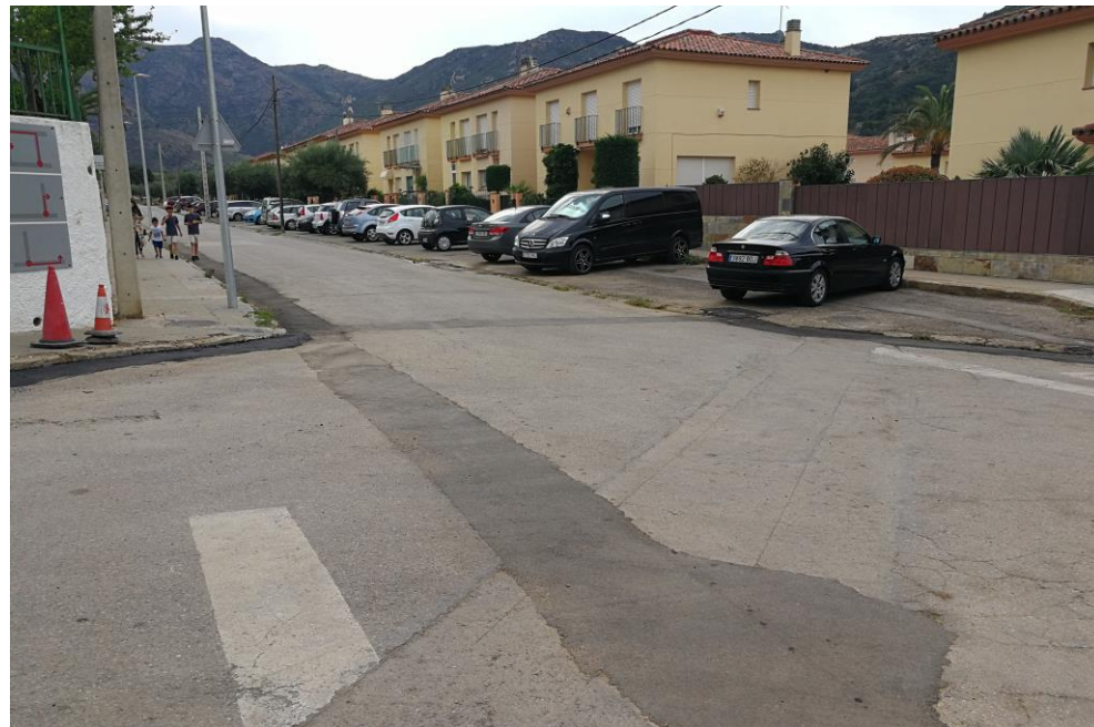
Rases visibles dels serveis existents que discorren per calçada.
