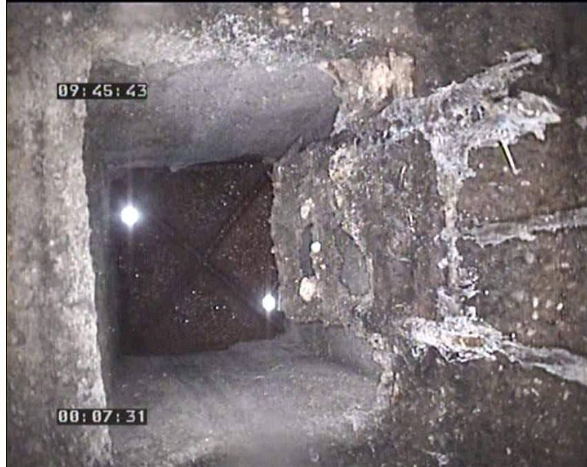
Foto: 22_1_1_16102008_095041_A.JPG 0m, Inicio de la inspección
