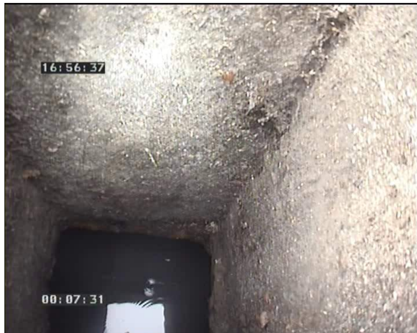
Foto: 27_1_1_16102008_170131_B.JPG 0m, Inicio de la inspección
