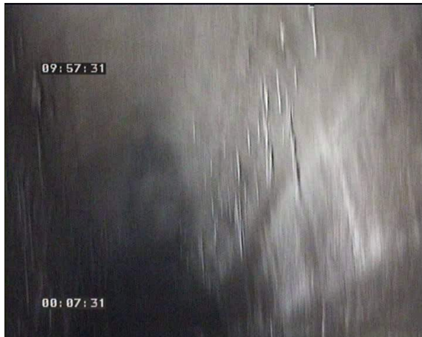
Foto: 22_1_6_16102008_100422_A.JPG 35m, Filtraciones
