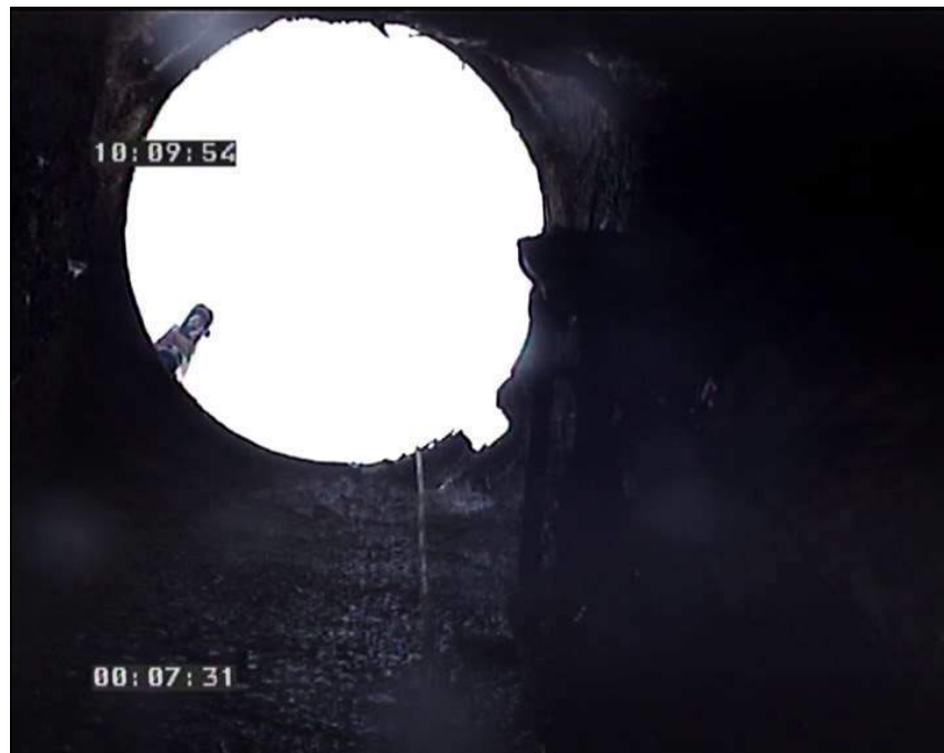
Foto: 22_1_8_16102008_101442_A.JPG 50m, Fin de la inspección
