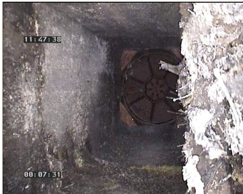
Foto: 23_1_13_16102008_115245_B.JPG 52,94m, Fin de la inspección
