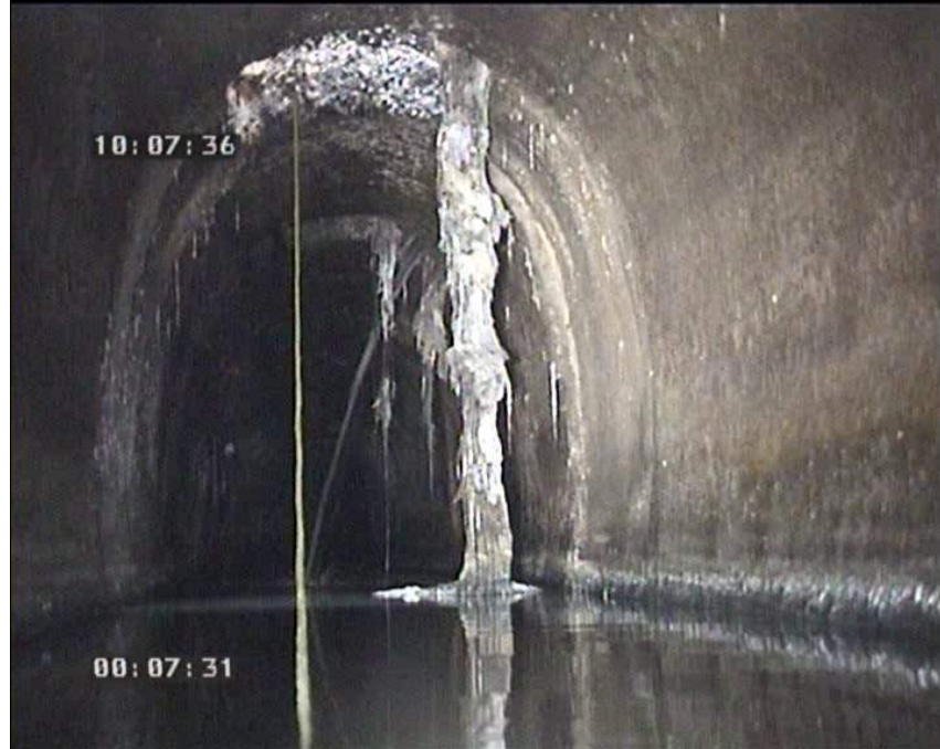
Foto: 22_1_7_16102008_101309_A.JPG 45,94m, Restos de la escalera de salida
