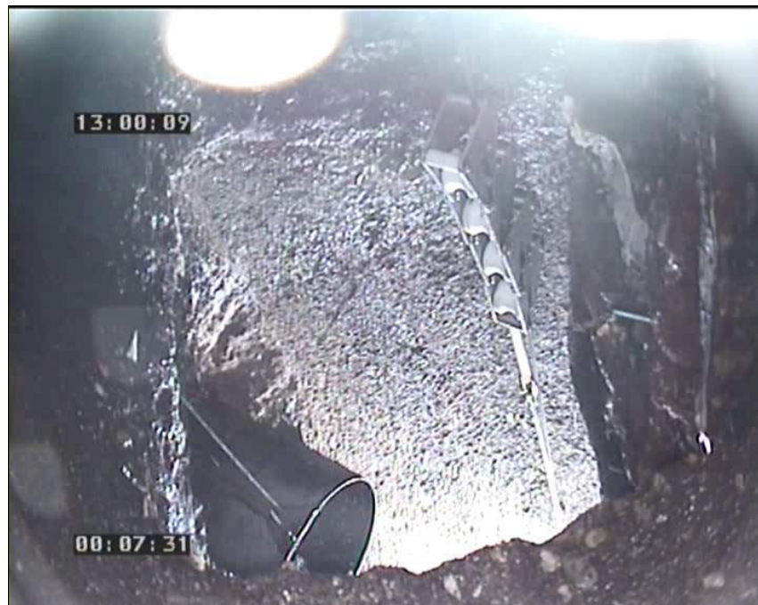
Foto: 25_1_1_16102008_130503_B.JPG 0m, Inicio de la inspección
