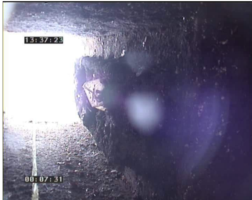
Foto: 26_1_10_16102008_134211_B.JPG 50,91m, Fin de la inspección
