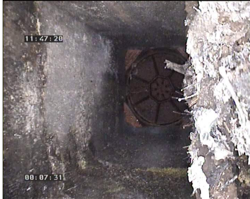
Foto: 23_1_13_16102008_115228_A.JPG 52,94m, Fin de la inspección
