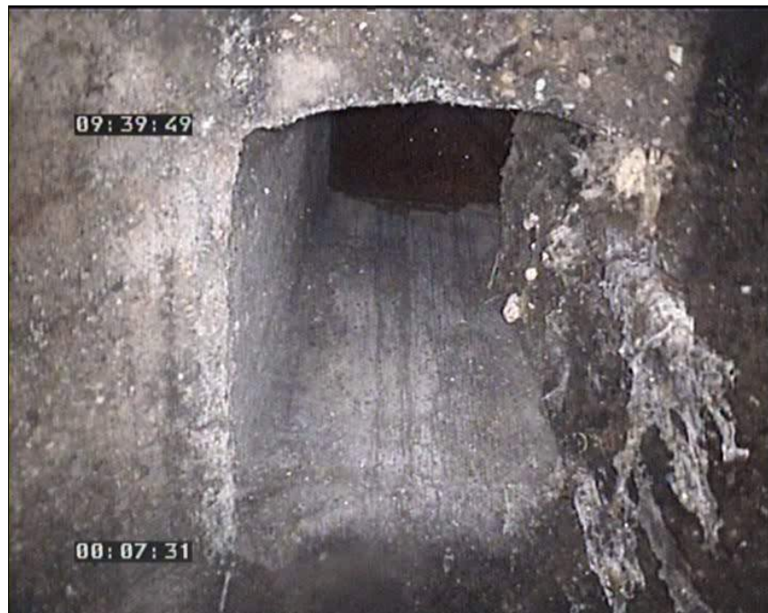
Foto: 21_1_8_16102008_094529_A.JPG 51m, Fin de la inspección
