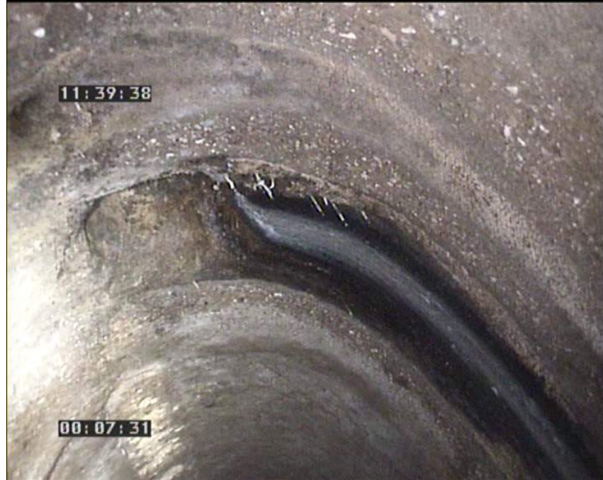
Foto: 23_1_10_16102008_114431_B.JPG 31,03m, Entronque en la clave
