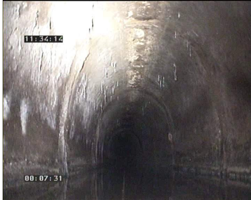
Foto: 23_1_8_16102008_113904_B.JPG 24,69m, Junta abierta hasta la clave
