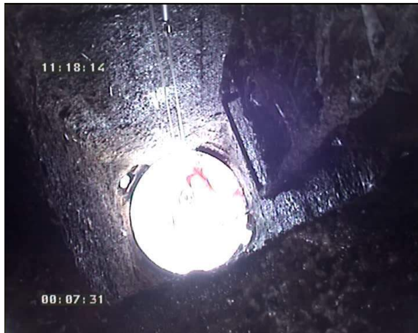
Foto: 23_1_1_16102008_112330_B.JPG 0m, Inicio de la inspección
