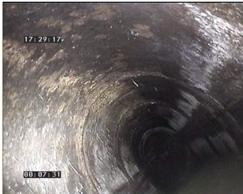
Foto: 27_1_14_16102008_173409_A.JPG 41,98m, Tunnel de continuacion
