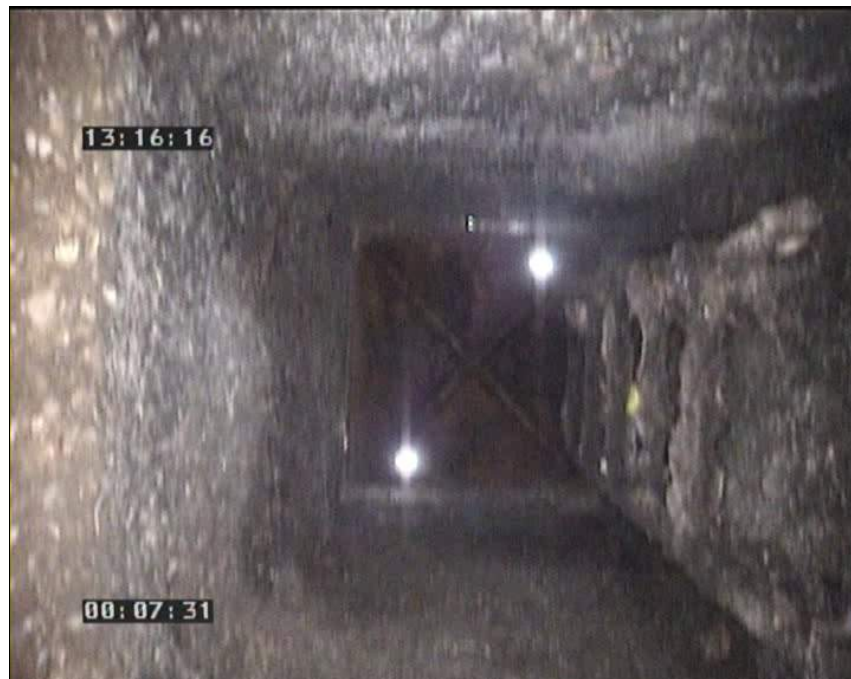
Foto: 26_1_1_16102008_132121_B.JPG 0m, Inicio de la inspección
