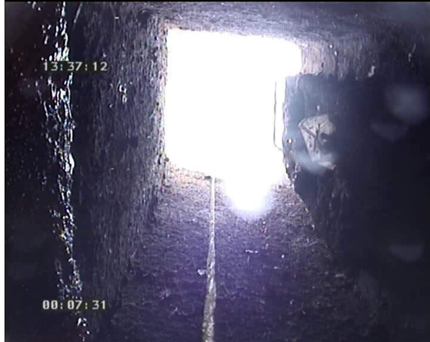
Foto: 26_1_10_16102008_134200_A.JPG 50,91m, Fin de la inspección
