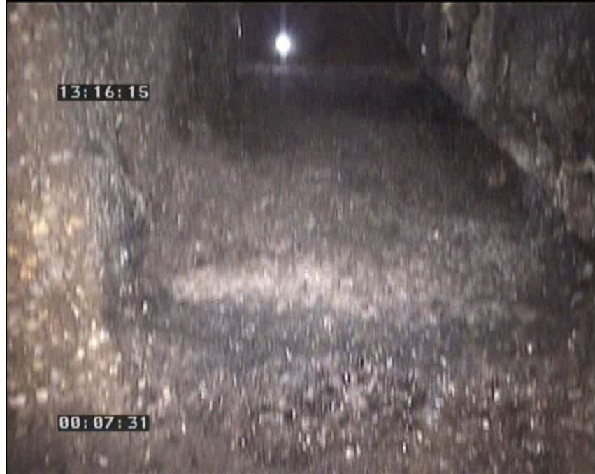
Foto: 26_1_1_16102008_132057_A.JPG 0m, Inicio de la inspección
