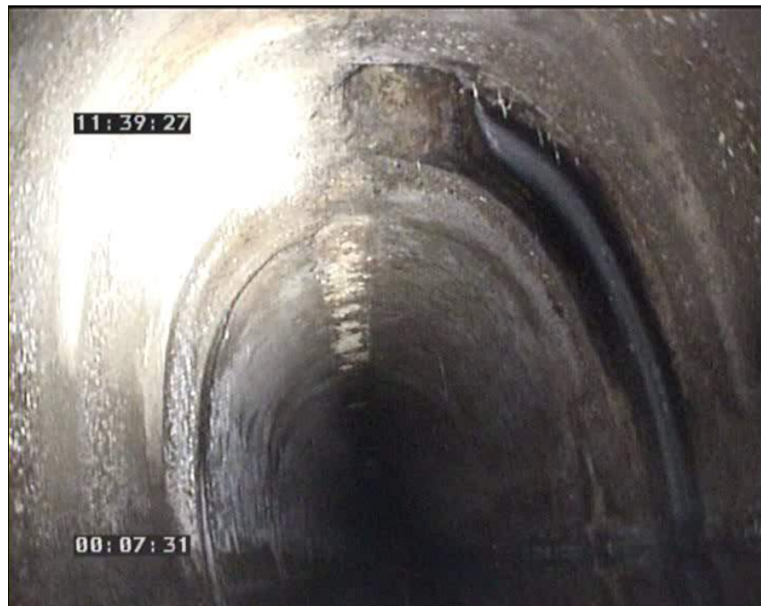
Foto: 23_1_10_16102008_114415_A.JPG 31,03m, Entronque en la clave
