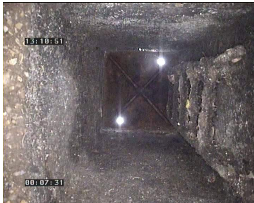
Foto: 25_1_6_16102008_131555_A.JPG 48,88m, Fin de la inspección
