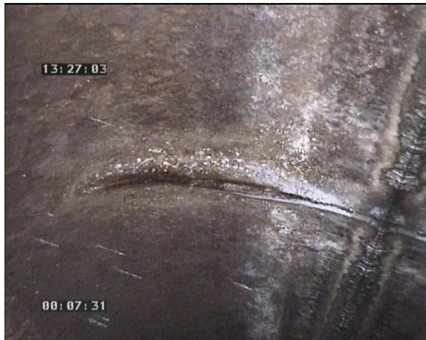
Foto: 26_1_6_16102008_133157_B.JPG 32,5m, Desconchones en la clave
