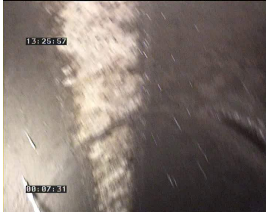
Foto: 26_1_6_16102008_133121_A.JPG 32,5m, Desconchones en la clave
