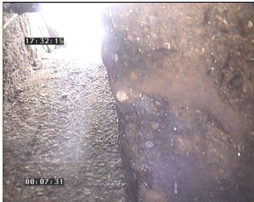
Foto: 27_1_14_16102008_173702_A.JPG 40,9m, TAPA B8 Final del recorrido
