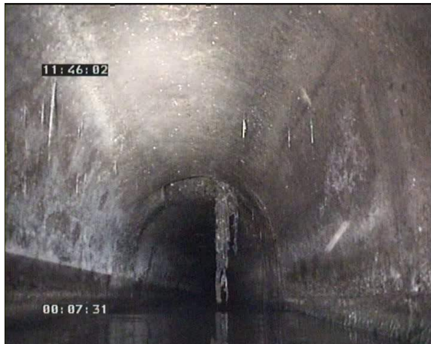
Foto: 23_1_12_16102008_115126_A.JPG 51,23m, Restos de la escalera al exterior
