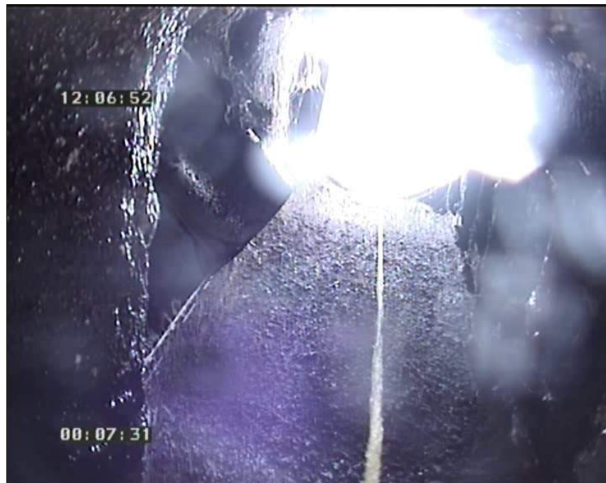
Foto: 24_1_9_16102008_121140_B.JPG 49,16m, Fin de la inspección
