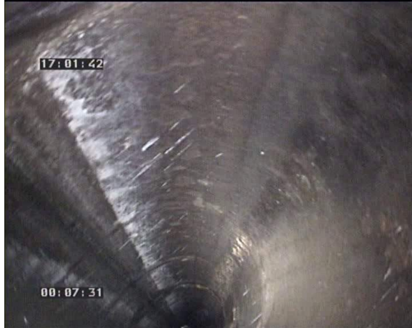
Foto: 27_1_3_16102008_170706_A.JPG 0,79m, Junta rota
