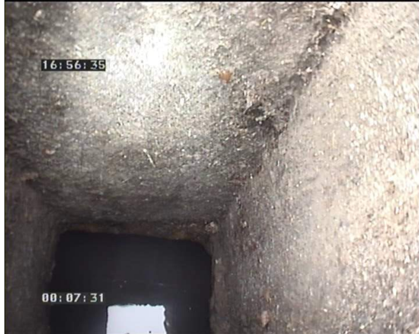
Foto: 27_1_1_16102008_170123_A.JPG 0m, Inicio de la inspección
