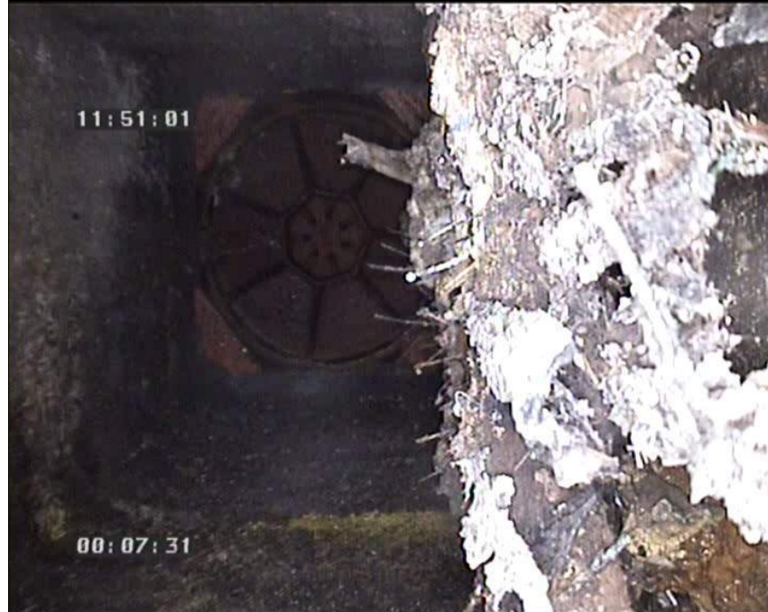
Foto: 24_1_1_16102008_115555_A.JPG 0m, Inicio de la inspección
