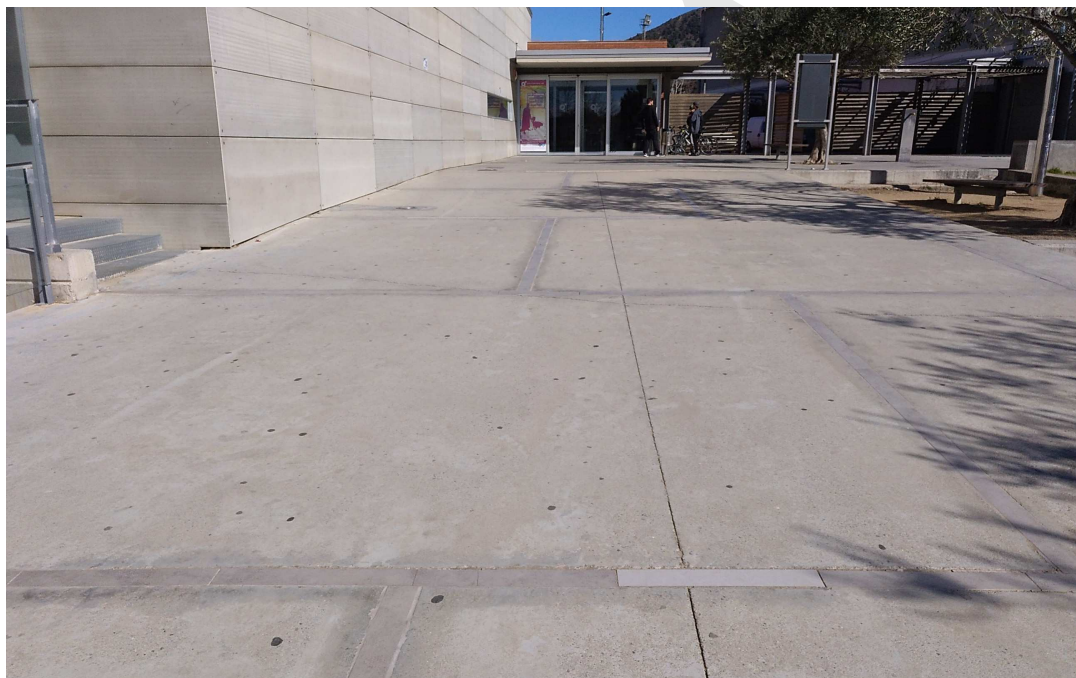
Figura 5.- Detall d'elles pastilles de formigó que formen el paviment actual
