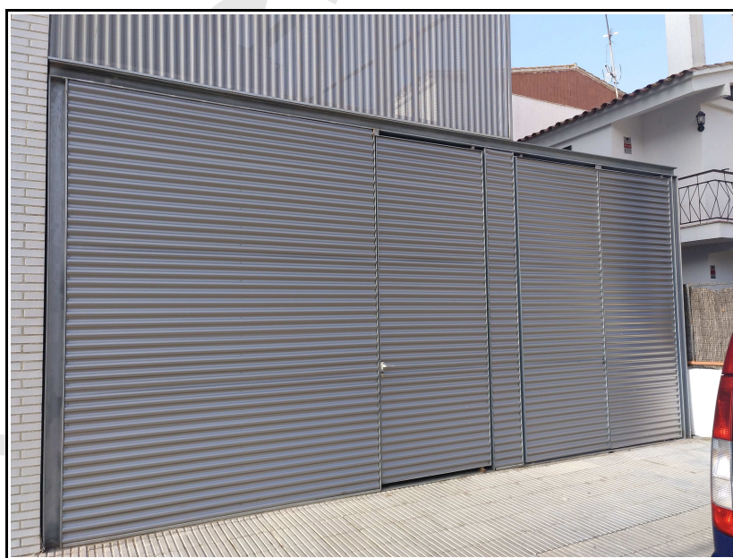
Figura 6.- Exemple de revestiment exterior ondulat sense perforar a la part baixa i perforat a la part alta, amb portes completament integrades.
