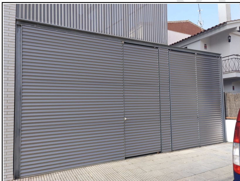
Figura 4.- Exemple de revestiment exterior ondulat sense perforar a la part baixa i perforat a la part alta
