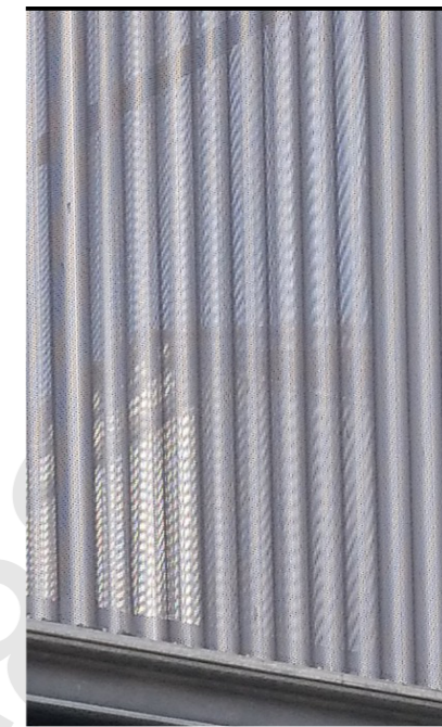
Figura 2.- Exemple de xapa ondulada i perforada galvanitzada i precalada de color gris
