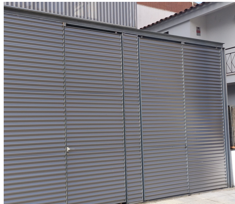
Figura 1.- Exemple de porta revestida de xapa ondulada lacada de color gris, totalment integrada de 3x3m amb doble batent
