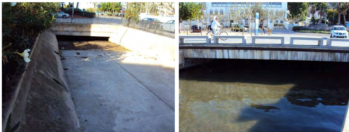
Figura 6. Vista aigua amunt (esquerra) i aigua avall (dreta) del pont de l'av. Rhode
