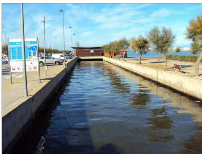
Figura 7. Vista de la desembocadura de la secció d'endegament de la riera de la Quana (moll de la Perola)
