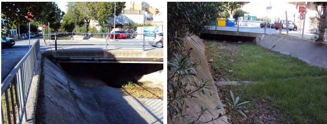
Figura 5. Vista del pont de la Gran Via de Pau Casals (esquerra) i del pont del carrer de l'Arquitecte Antoni Gaudí (dreta)
