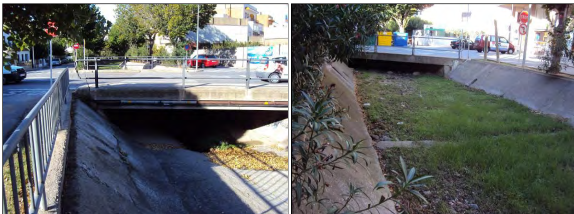
Figura 5. Vista del pont de la Gran Via de Pau Casals (esquerra) i del pont del carrer de l'Arquitecte Antoni Gaudí (dreta)
