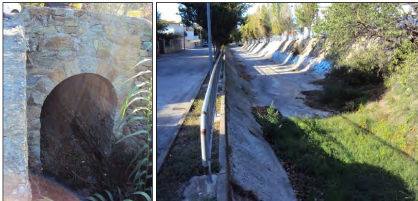
Figura 3. Vista del pont existent en l'extrem d'aigua amunt (esquerra) i de la secció d'endegament de la llera a l'inici del tram (dreta)
