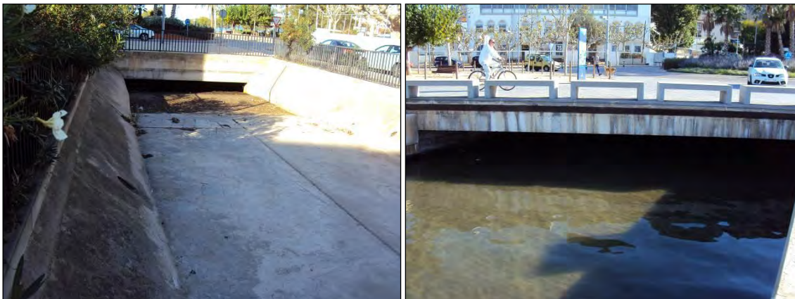
Figura 6. Vista aigua amunt (esquerra) i aigua avall (dreta) del pont de l'av. Rhode
