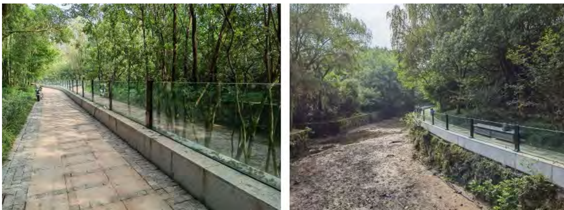
Figura 20. Imatges de la barana de vidre tipus proposada sobre vorera
